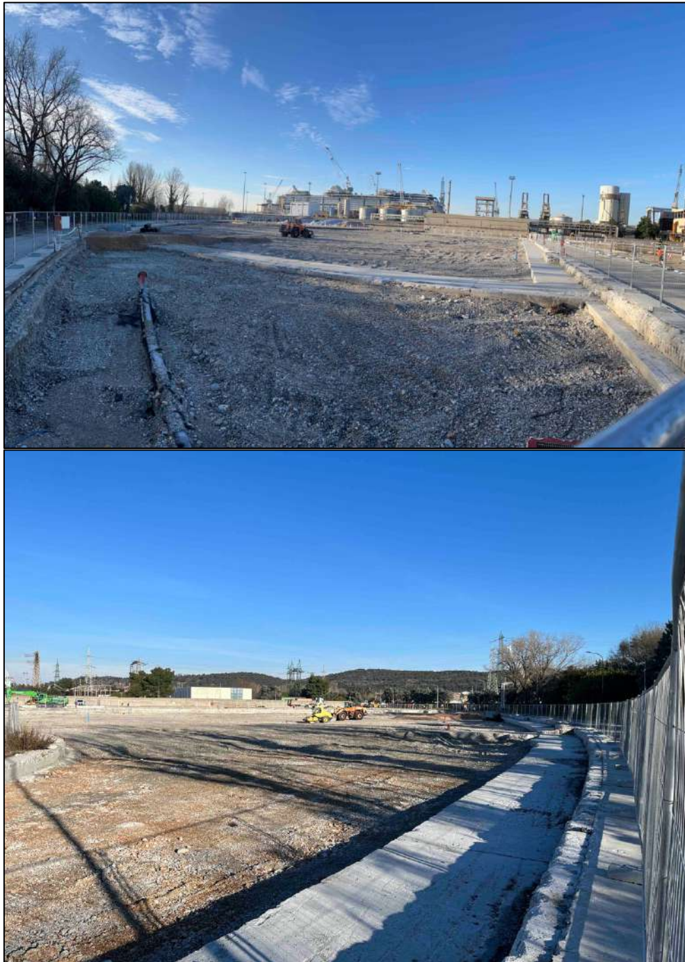
Figura 13 – Aree ex serbatoi n. 4 e 5 (Foto del 06/02/2024)
