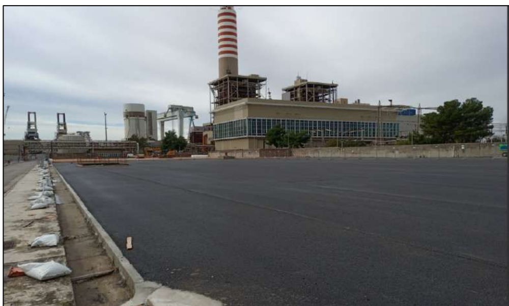
Figura 12 – Aree ex serbatoio 1 ed ex serbatoio 2 (Foto del 06/03/2024)
