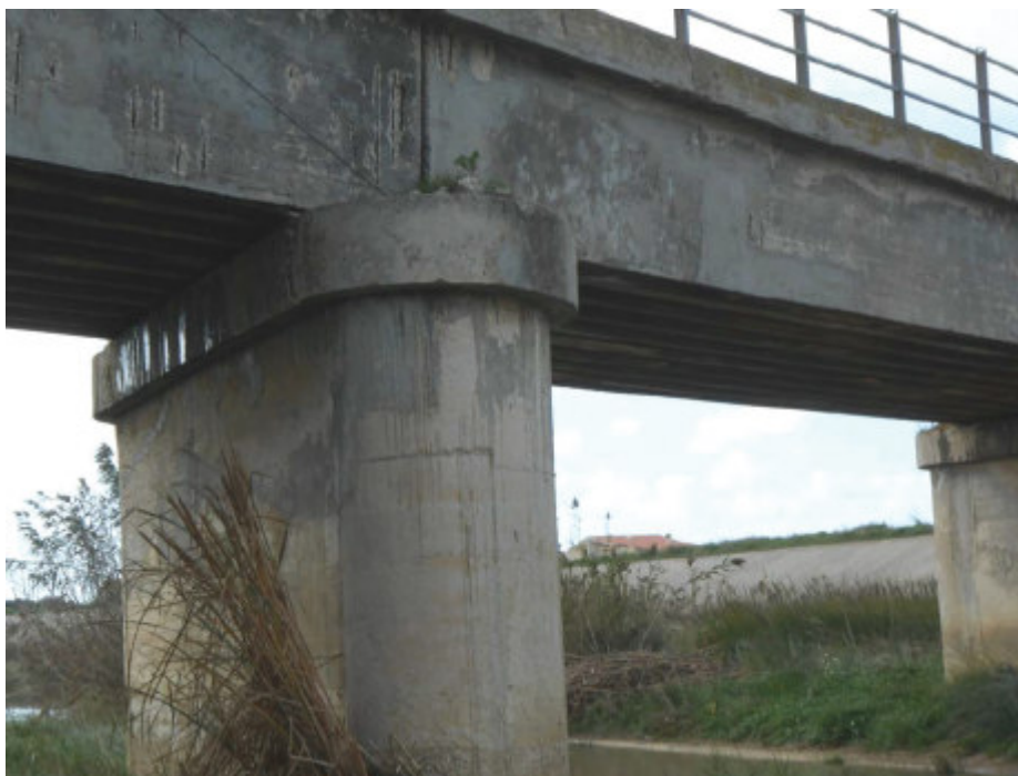
Figura 2-4 Viadotto in calcestruzzo di attraversamento del canale di Xitta
