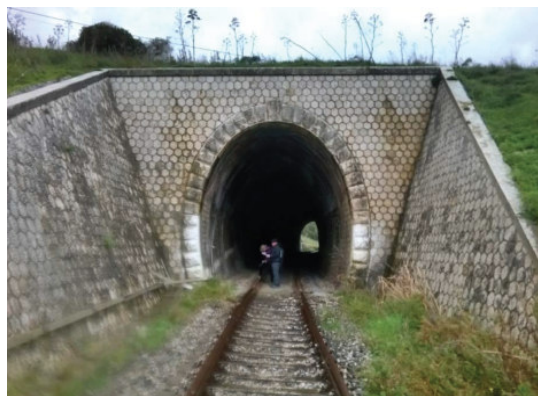
Figura 2-3 Sezione di progetto delle gallerie e imbocco con rivestimento in blocchi di pietra squadrata
