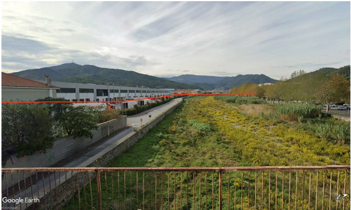
Figura 4.2/C – Torrente Quiliano, località via Briano (Ponte Strada di Scorrimento Veloce, foto da valle verso monte). La linea rossa rappresenta Il metanodotto in progetto.
