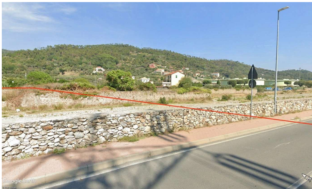
Figura 4.2/B – Confluenza Trexenda-Quazzola, località via 25 Aprile (foto da monte verso valle). La linea rossa rappresenta il metanodotto in progetto.
