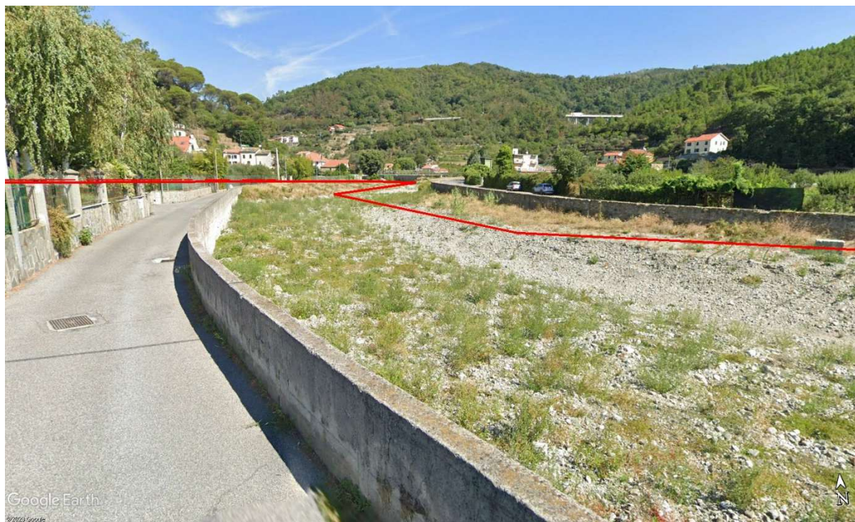
Figura 4.2/A – Torrente Quazzola, località via Quazzola (foto da valle verso monte). La linea rossa rappresenta il metanodotto in progetto.
