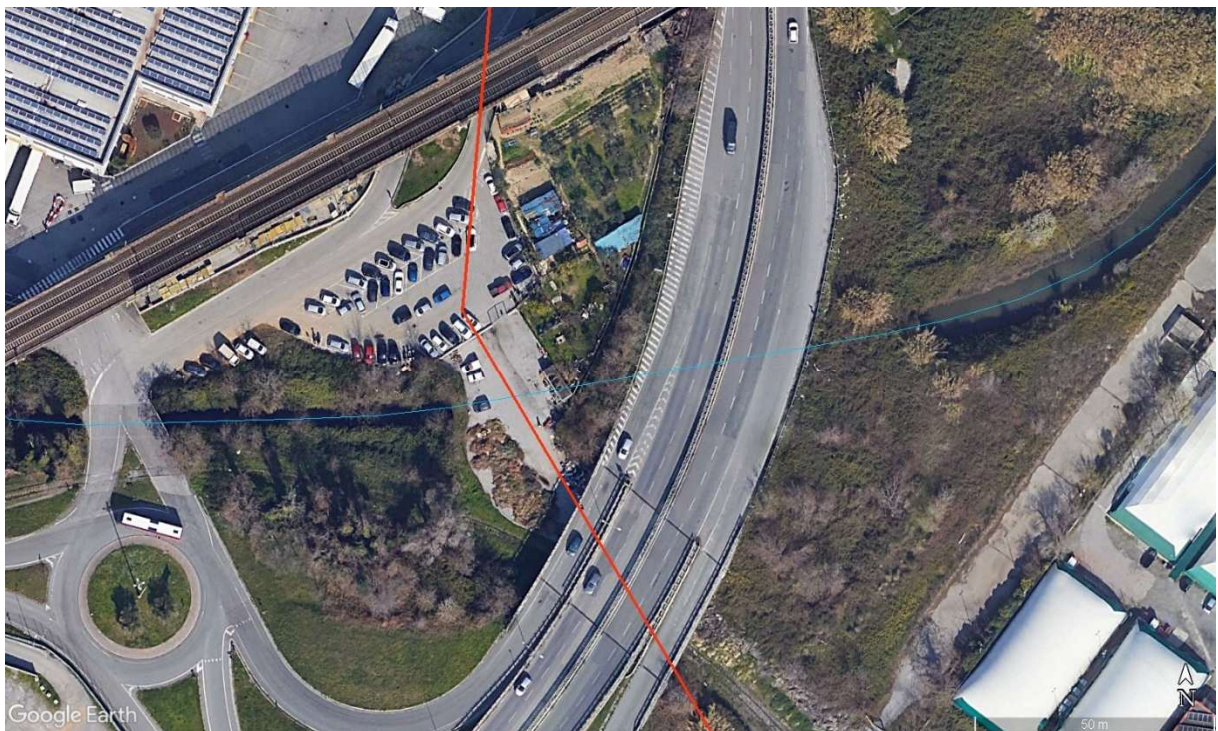
Figura 4.2/D – Rio Villeggia, località via Briano (Ponte Strada di Scorrimento Veloce, foto aerea). La linea rossa rappresenta Il metanodotto in progetto.
