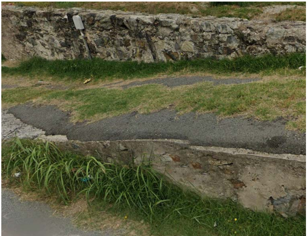
Figura 7: Rampa esistente denominata ID5 -tratto asfaltato
