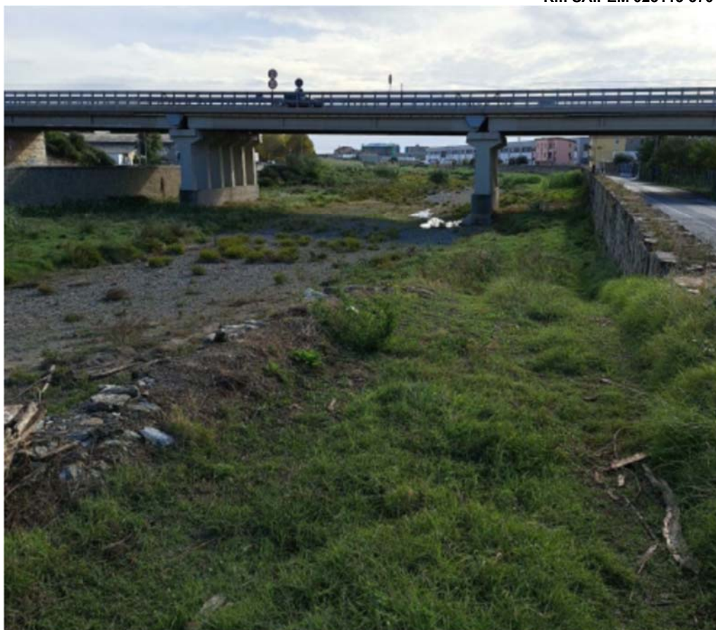
Figura 4: Viabilità provvisoria ID5, vista della rampa di accesso.
