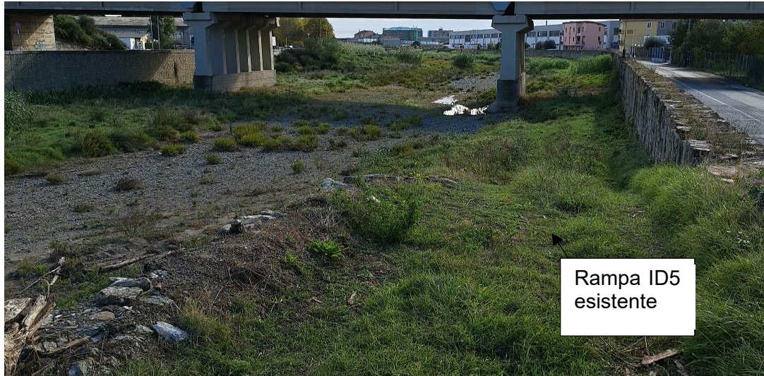
Figura 6: Rampa esistente denominata ID5 – tratto non asfaltato
