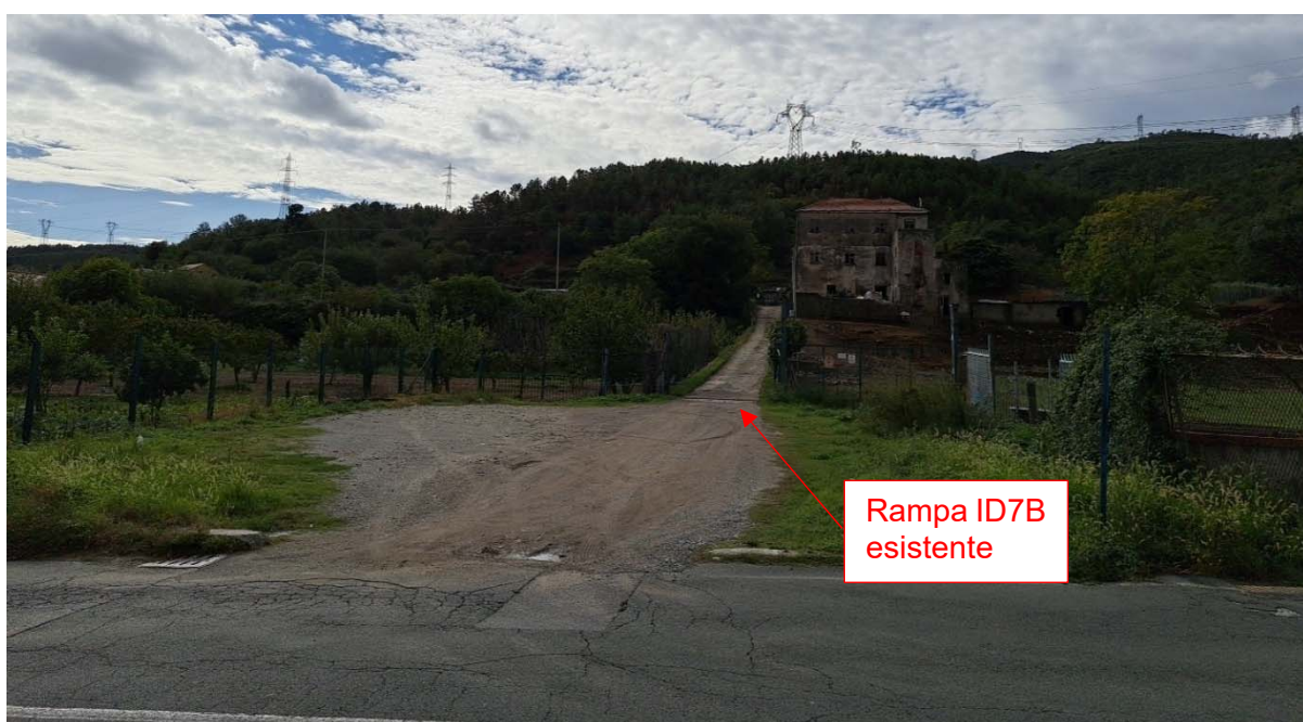
Figura 6: Rampa esistente denominata ID7B – Vista 1
