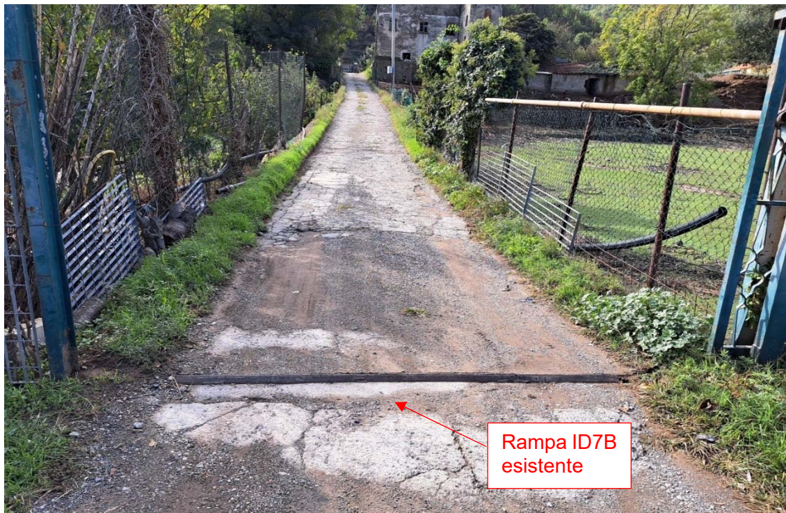
Figura 7: Rampa esistente denominata ID7B – Vista2
