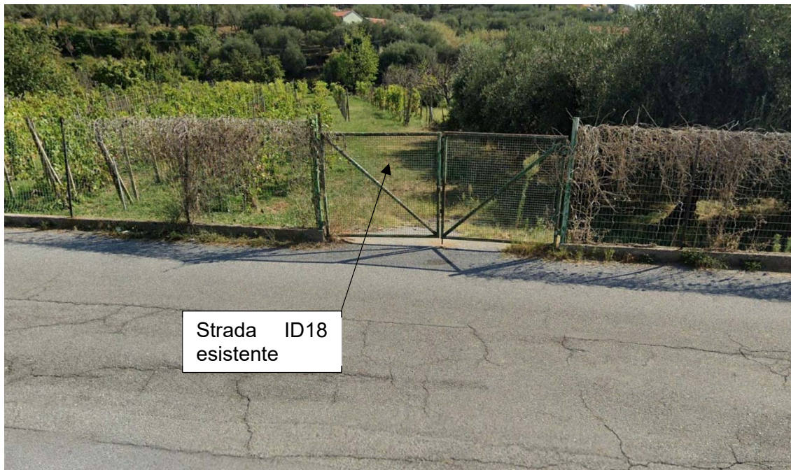
Figura 8: Strada esistente denominata ID18
