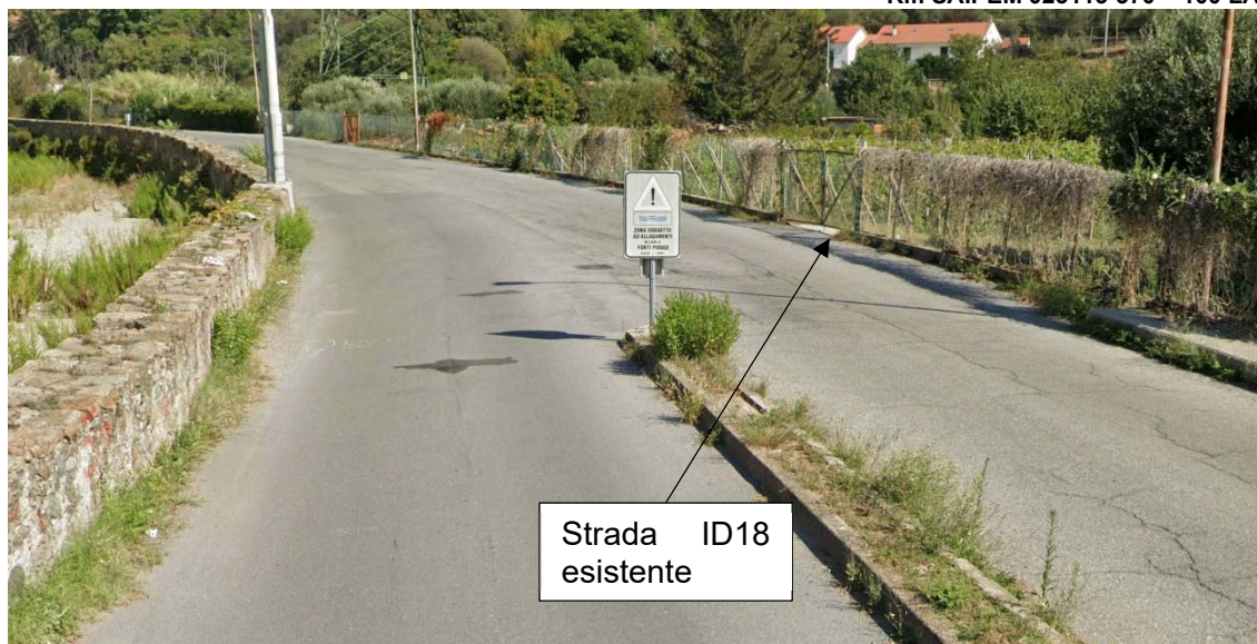
Figura 6: Accesso da Via Tecci alla strada esistente denominata ID18 – Vista 2
