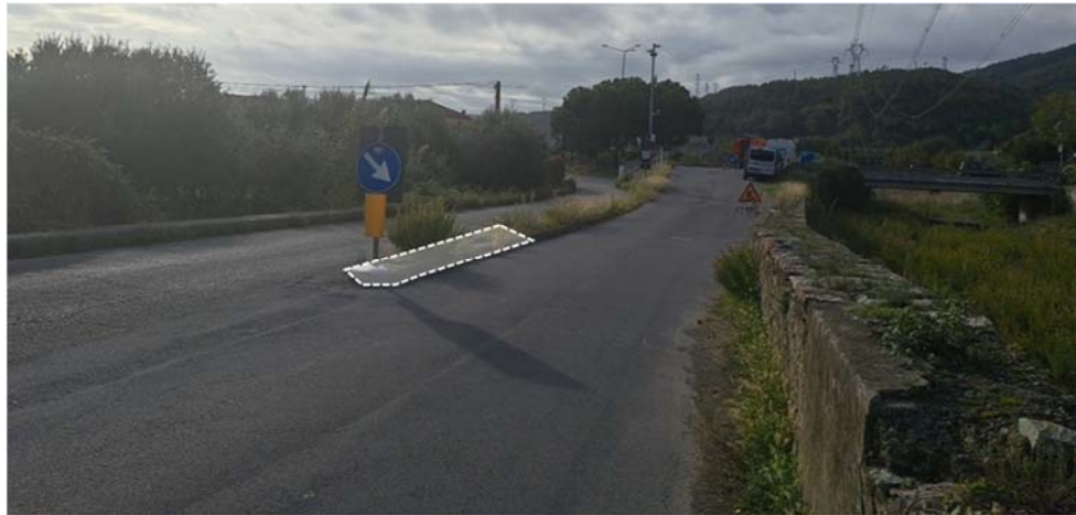
Figura 10: Rimozione temporanea della parte terminale dell'Isola spartitraffico su Via Tecci
