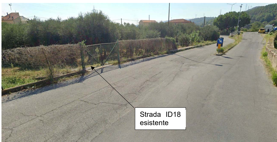
Figura 5: Accesso da Via Tecci alla strada esistente denominata ID18 – Vista 1
