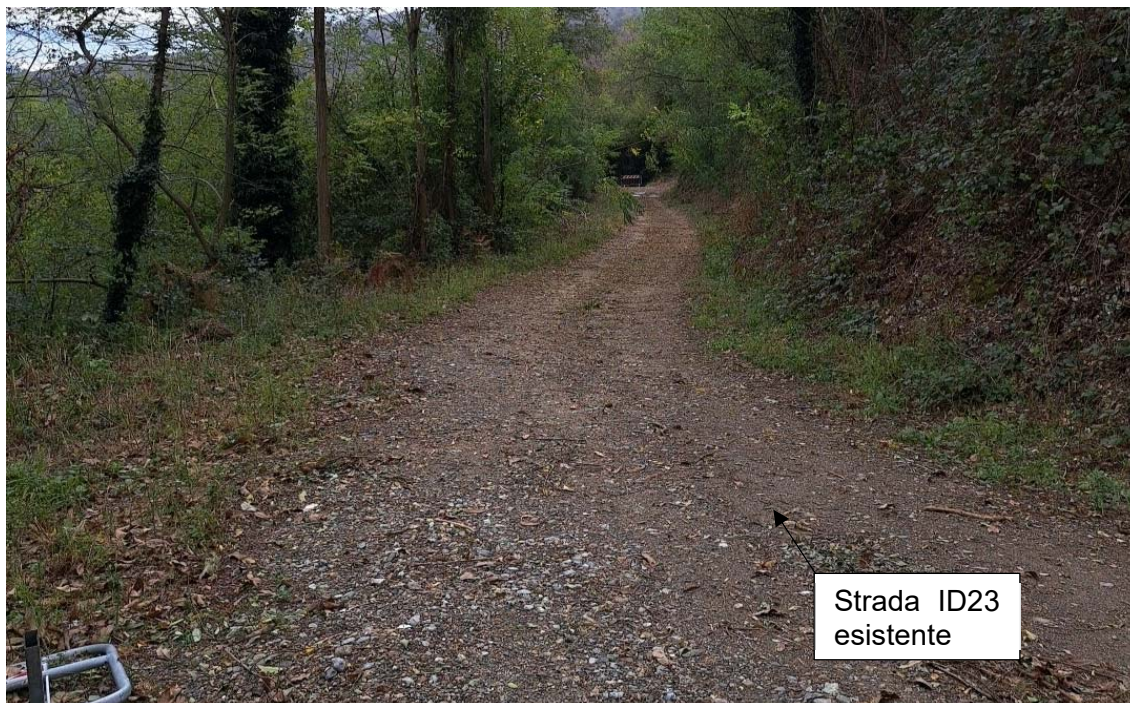
Figura 6: Strada esistente denominata ID23 – Vista1
