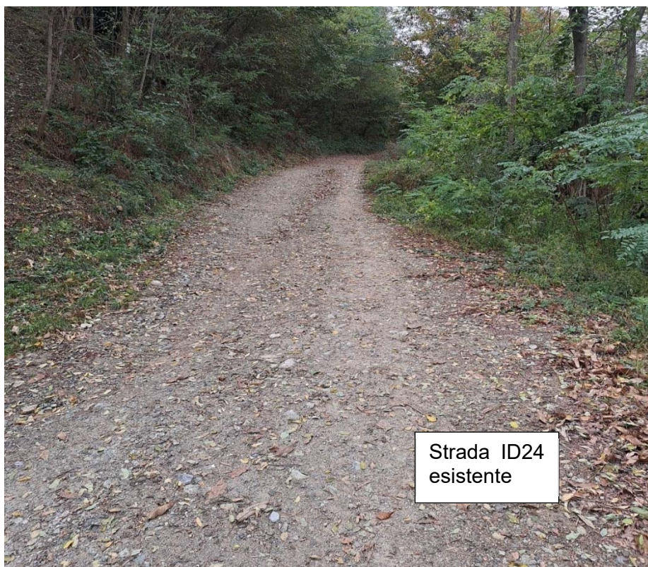
Figura 5: Strada provvisoria di cantiere ID24 che conduce ad ID23
