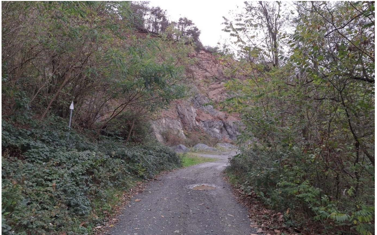
Figura 8: Strada esistente denominata ID24 – Vista2
