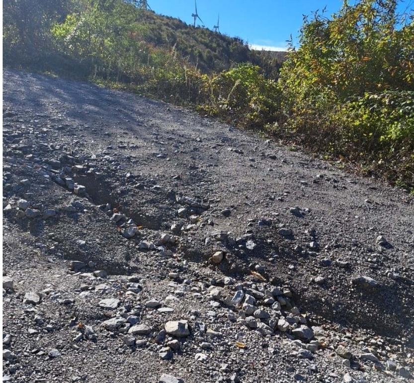
*Figura 21: Strada ID25 zona soggetta a dilavamento della pavimentazione*
