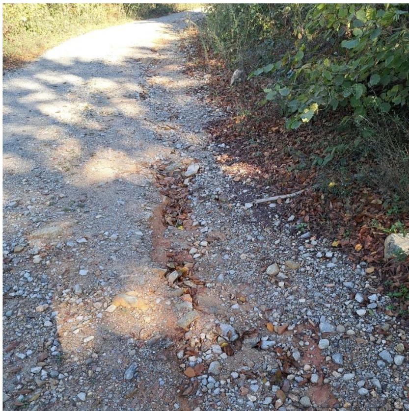
*Figura 22: Strada esistente ID25 zona soggetta a dilavamento della pavimentazione*
