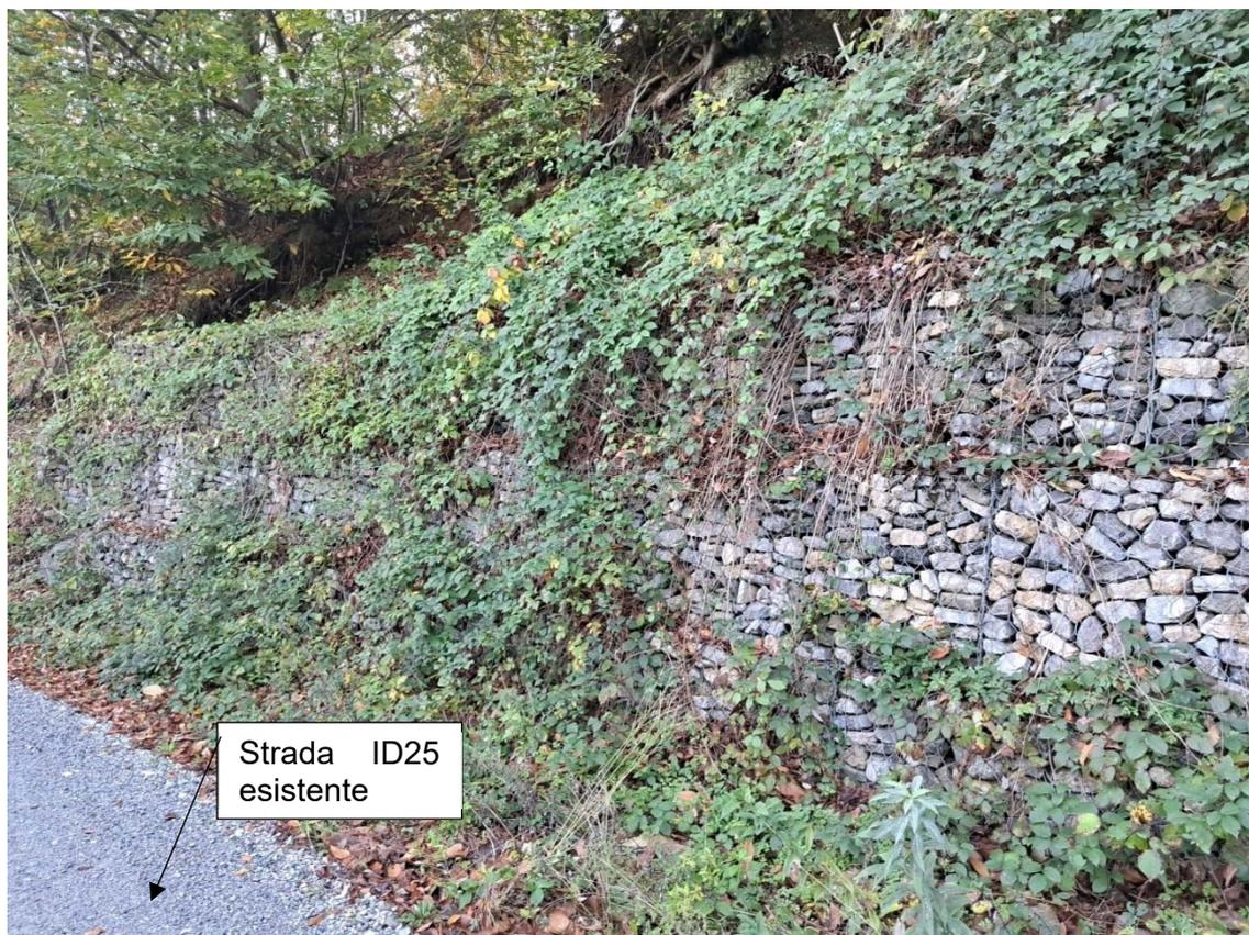
*Figura 9: Opera di sostegno laterale*
