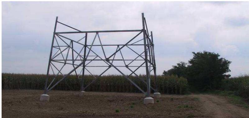
Poiché le fondazioni unificate sono utilizzabili solo su terreni normali di buona e media consistenza, per sostegni posizionati su terreni con scarse caratteristiche geomeccaniche, su terreni instabili o su terreni allagabili, sono progettate fondazioni speciali (pali trivellati, micropali, tiranti in roccia), sulla base di apposite indagini geotecniche.
