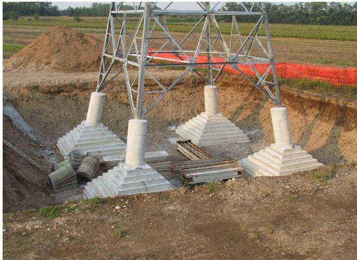
Di seguito viene raffigurato un esempio di reinterro e ripristino delle aree sostegno.
