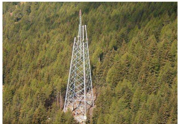
Il cantiere sarà organizzato per squadre specializzate nelle varie fasi di attività (scavo del terreno per la realizzazione delle fondazioni, getto dei blocchi di fondazione, montaggio dei tralicci, posa e tesatura dei conduttori), che svolgeranno il loro lavoro in successione sulle piazzole di realizzazione dei sostegni.
