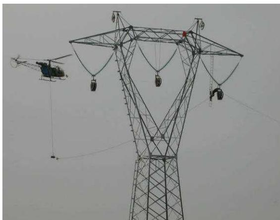
A questa fase segue lo stendimento dei conduttori che avviene recuperando la corda pilota con l'ausilio delle attrezzature di tiro, argani e freno, dislocate, come già detto in precedenza alle estremità della tratta oggetto di stendimento, la cui azione simultanea, definita "Tesatura frenata", consente di mantenere alti dal suolo, dalla vegetazione, e dagli ostacoli in genere, i conduttori durante tutte le operazioni.
