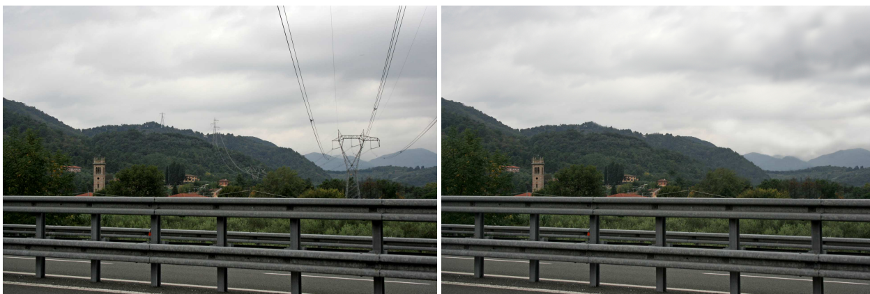
Figura 4.3-48: Interferenza della linea 380kV con l'Autostrada A11 (Bretella Lucca-Viareggio) in prossimità dell'abitato di Maggiano. Stato attuale (sinistra) e in seguito alla rimozione della linea (destra)
