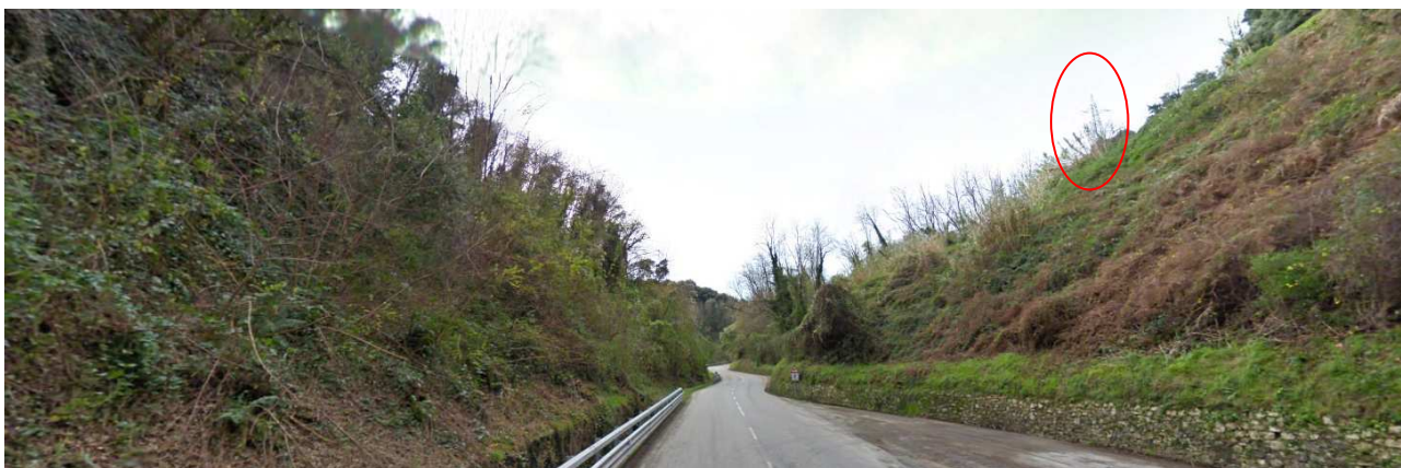
Figura 4.3-37: Vista dell'attraversamento della via Sarzanese della linea 132 kV in demolizione (loc. C. Folonico) (Google Street View)
