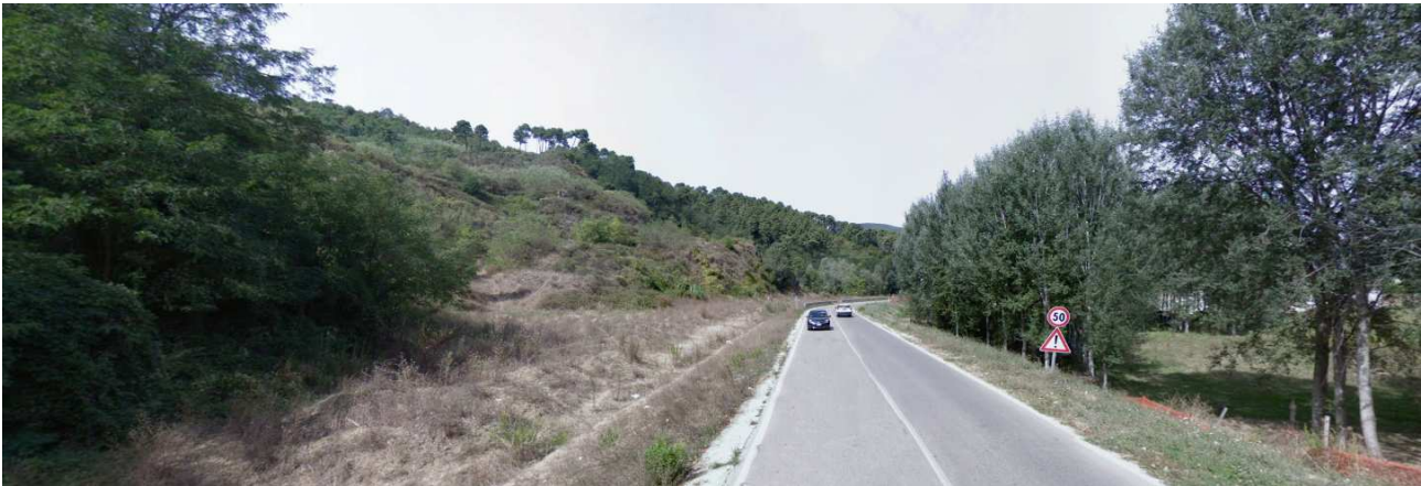
Figura 4.3-41: Vista dell'attraversamento della via del Lungomonte Pisano della linea 380 kV D.T. in progetto (loc. Laiano).
