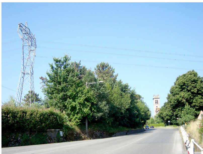
Figura 4.3-38: Vista dell'attraversamento della via Sarzanese della linea 380 kV in demolizione (loc. Maggiano)
