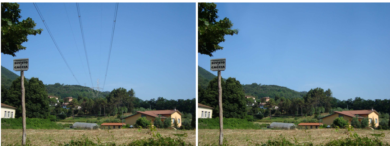
Figura 4.3-44: Interferenza della linea 380kV con l'abitato di Maggiano. Stato attuale (sinistra) e in seguito alla rimozione della linea (destra)
