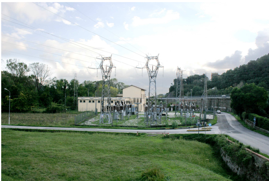
Figura 4.3-39: Vista dell'attraversamento della via del Lungomonte Pisano e dell'ingresso nella C.P. Filettole della linea 132 kV in demolizione (loc. Filettole)
