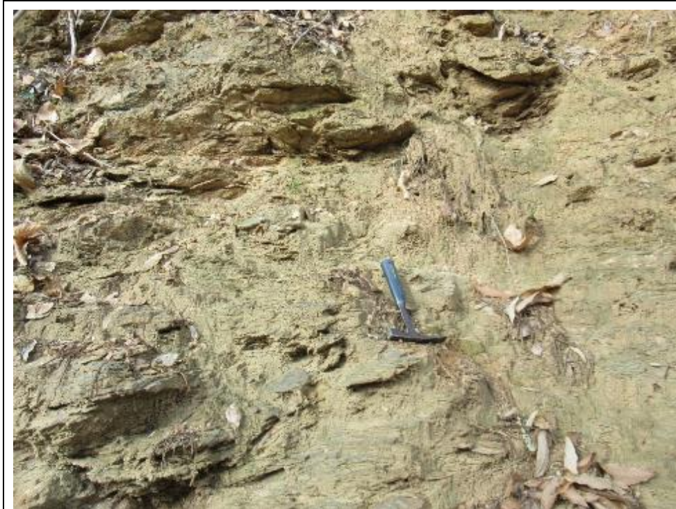
Fig. 7.1.9/C – Affioramento di scisti alterati della Formazione di Murialdo lungo la scarpata a monte dell'autostrada Torino – Savona
