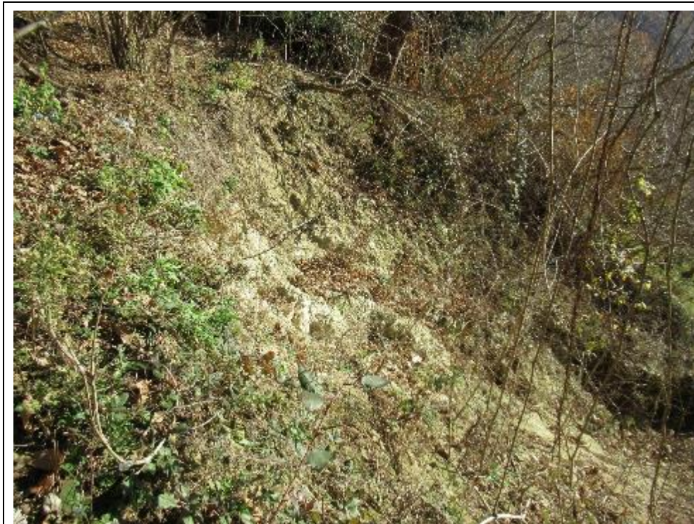
Fig. 7.1.6/C– Solco erosive nel versante Sud di Teggia Pertusio in prossimità del crinale
