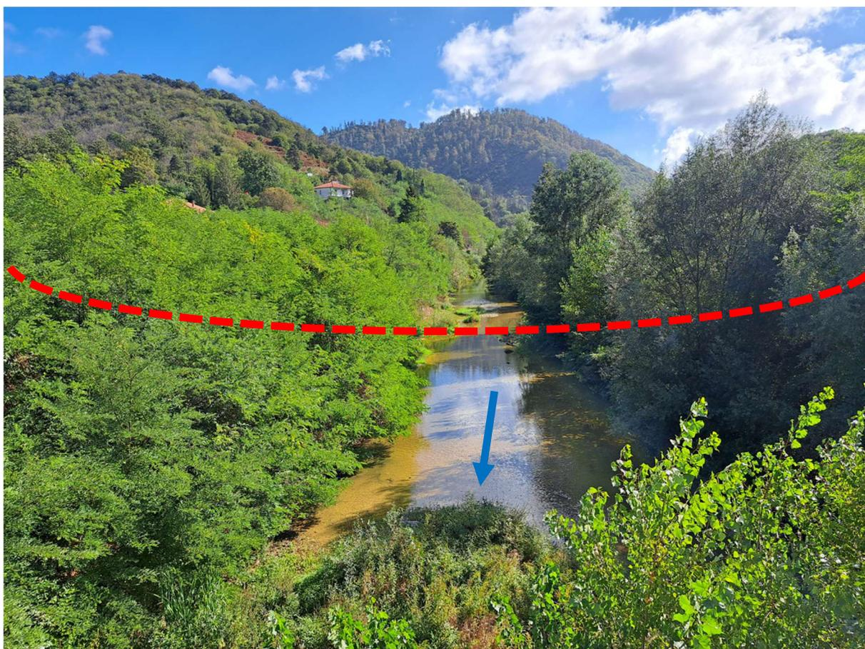
**Figura 4.2/C – Bormida di Mallare, 2° attraversamento (foto da valle verso monte). La linea rossa tratteggiata rappresenta il metanodotto in progetto (microtunnel)**
