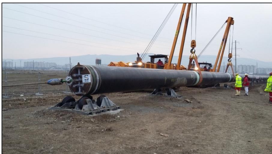
**Figura 4.31: Installazione della stringa di condotta nel microtunnel**
