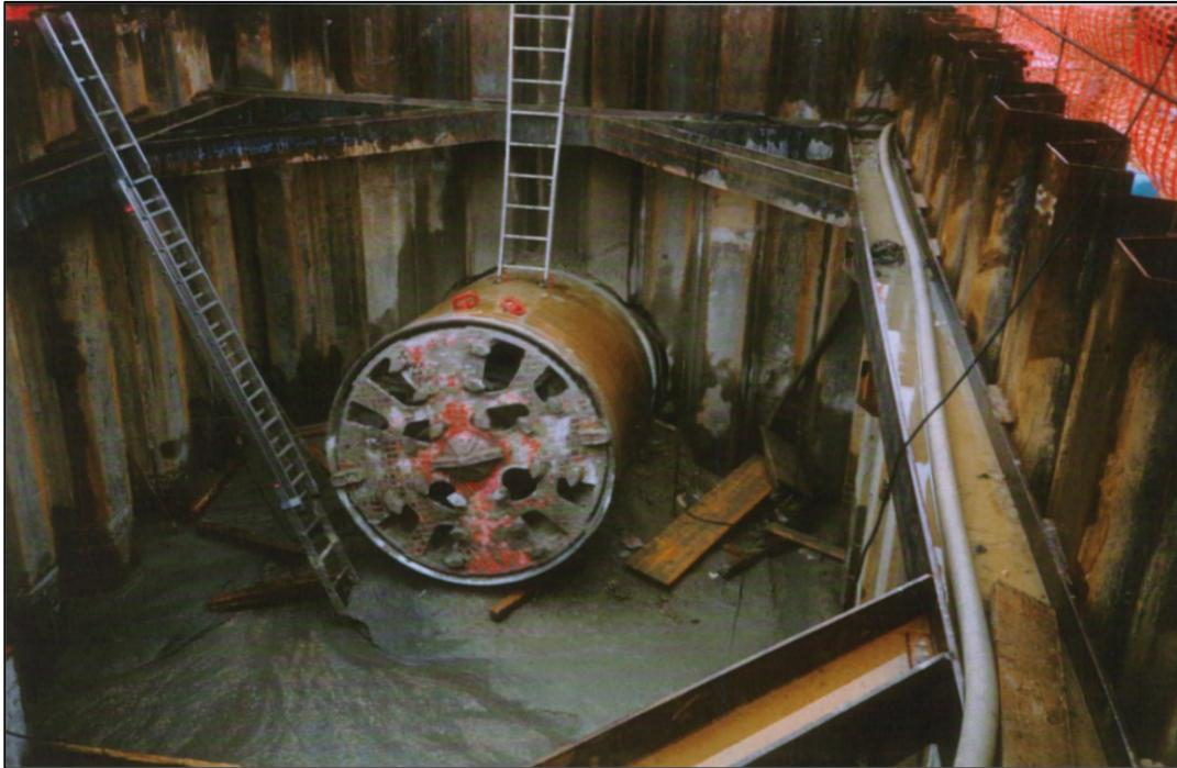
**Figura 4.26: Pozzo di recupero della fresa di un Microtunnel (MT)**
