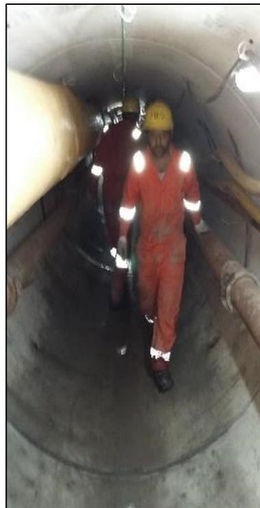
**Figura 4.25: Interno di un Microtunnel (MT) durante lo scavo**
