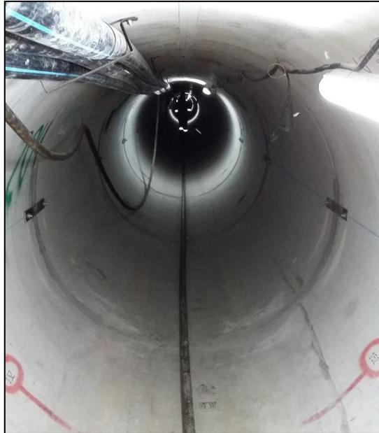
**Figura 4.28: Tunnel pronto per l’inserimento della condotta. La fune d’acciaio collegata all’argano è stesa sul fondo del MT**
