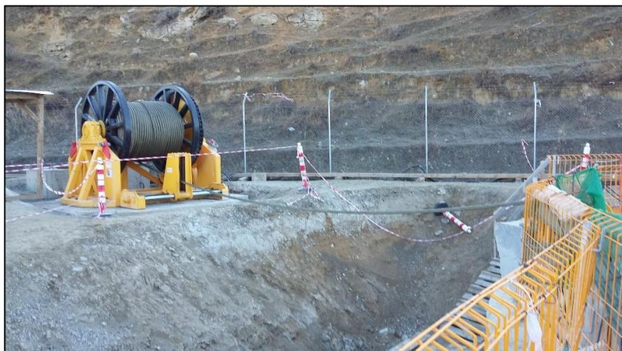
**Figura 4.27: Argano con fune d'acciaio per il tiro della condotta nel MT**
