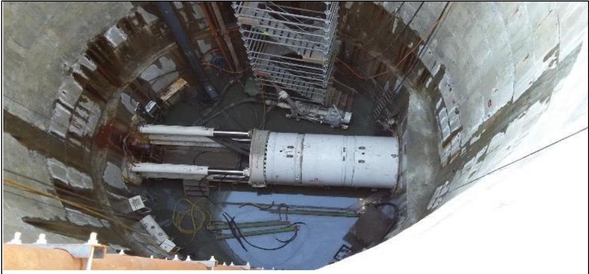
**Figura 4.24: Interno di un pozzo di lancio di un MT**
