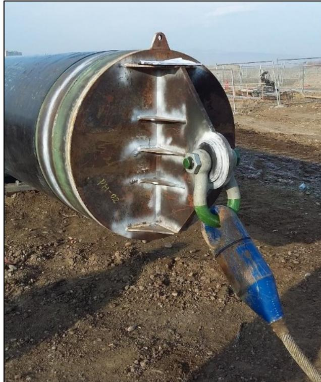
**Figura 4.30: Testa di tiro saldata alla stringa di condotta da inserire nel MT e collegamento con la fune d'acciaio collegata all'argano**
