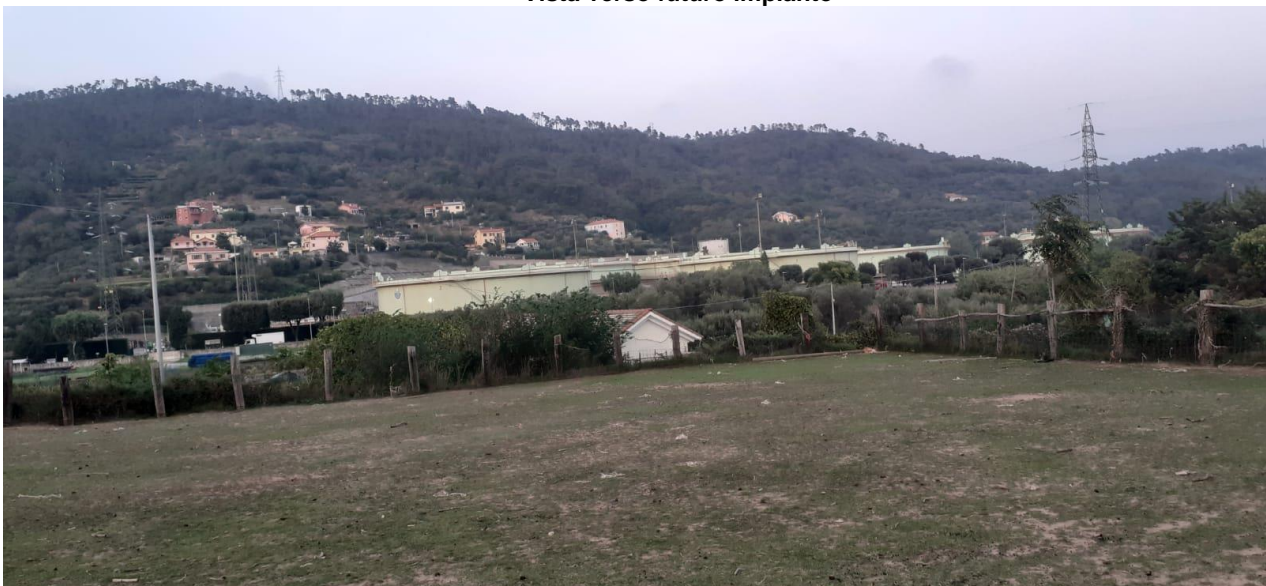
Vista verso futuro impianto
