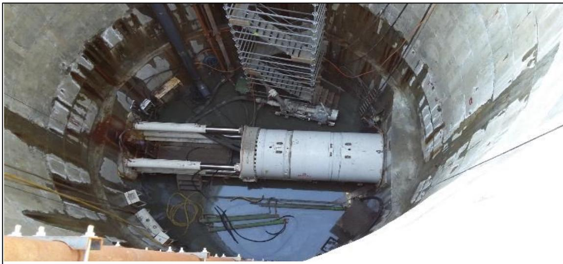
**Figura 2.25: Interno di un pozzo di lancio di un MT**
