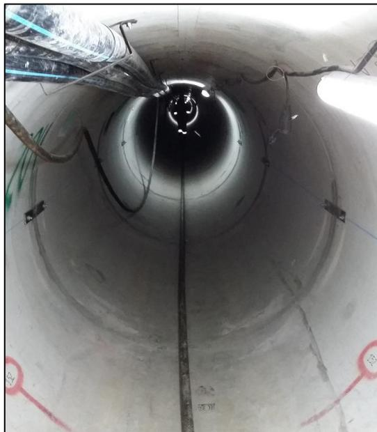
**Figura 2.29: Tunnel pronto per l'inserimento della condotta. La fune d'acciaio collegata all'argano è stesa sul fondo del MT**
