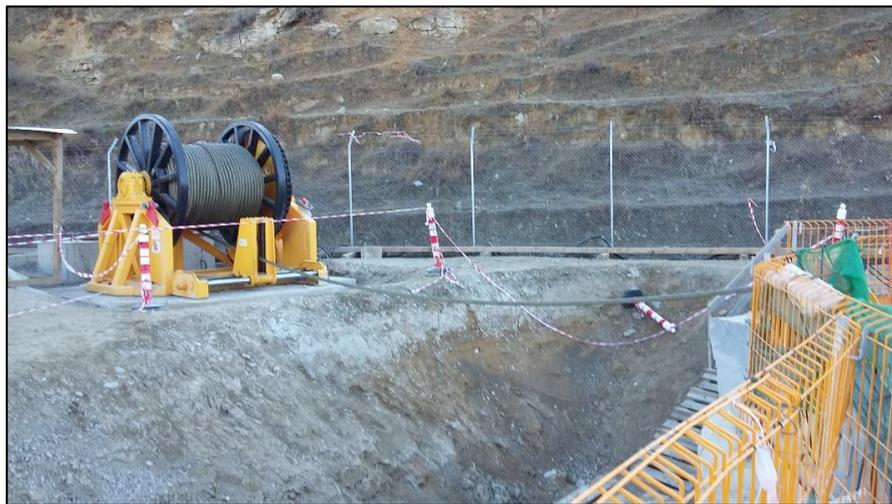
**Figura 2.28: Argano con fune d'acciaio per il tiro della condotta nel MT**
