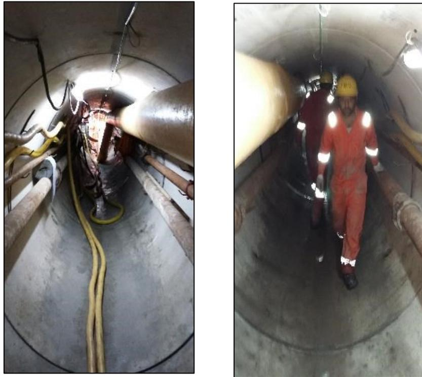
**Figura 2.26: Interno di un Microtunnel (MT) durante lo scavo**
