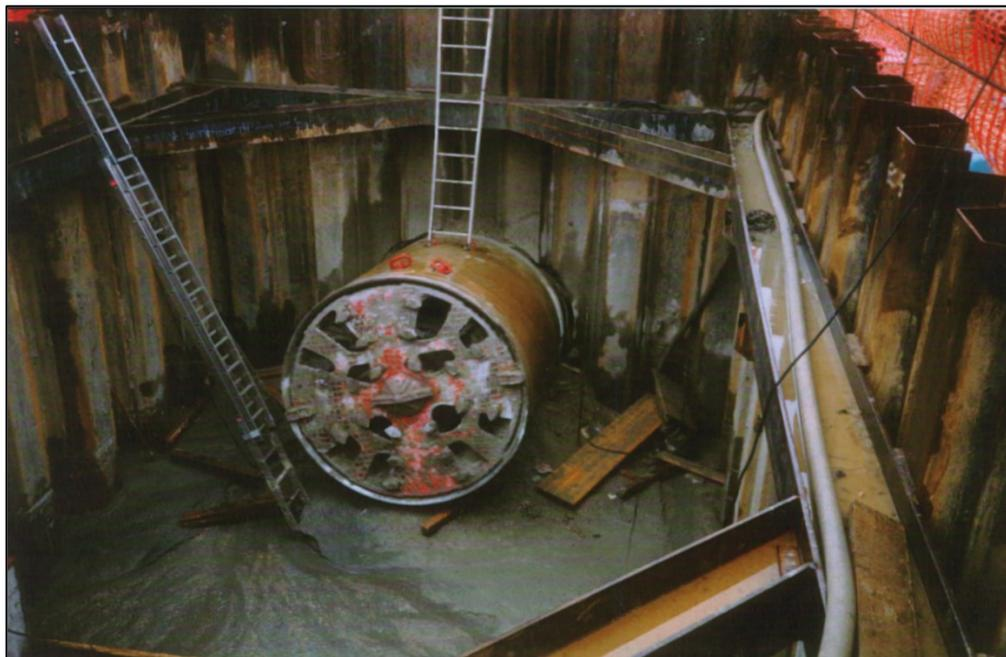
**Figura 2.27: Pozzo di recupero della fresa di un Microtunnel (MT)**
