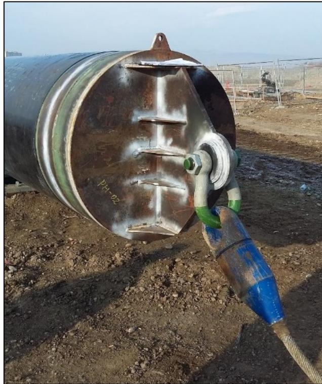
**Figura 2.31: Testa di tiro saldata alla stringa di condotta da inserire nel MT e collegamento con la fune d'acciaio collegata all'argano**
