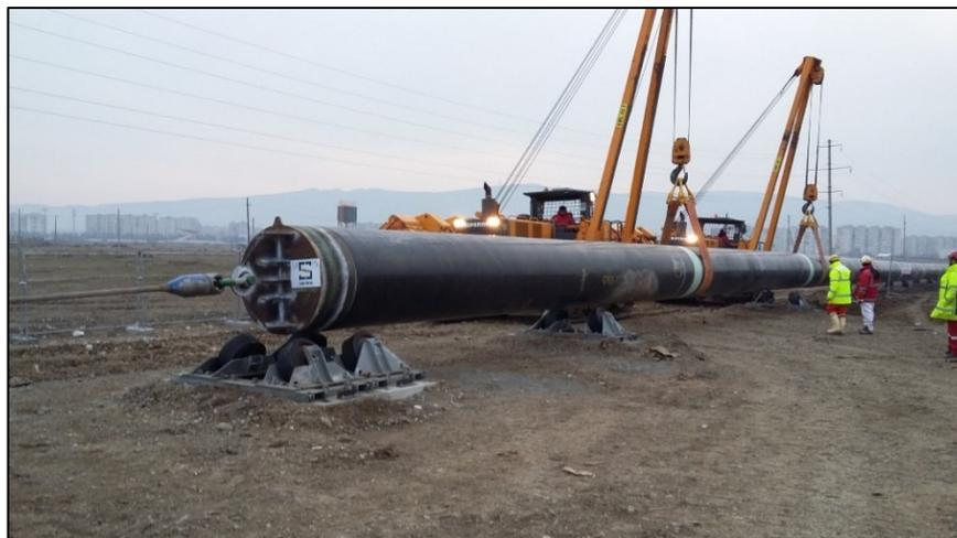
**Figura 2.32: Installazione della stringa di condotta nel microtunnel**
