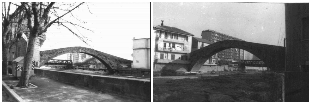
Figura 4.6: Ponte sul Torrente Quiliano
