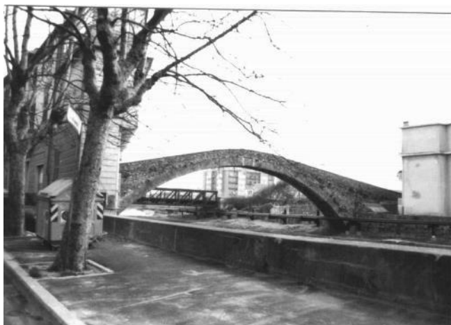
Figura 4.51: Foto "Ponte Saraceno sul Torrente Quiliano" (Fonte: vincoli Regione Liguria - http://www.liguriavincoli.it )
