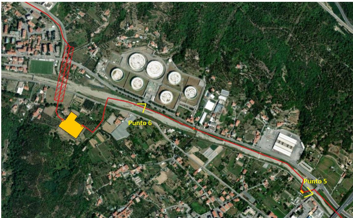
Figura 6.2: Ubicazione punti di osservazione PIL 2 e Impianto PDE di Quiliano e impianto di regolazione
