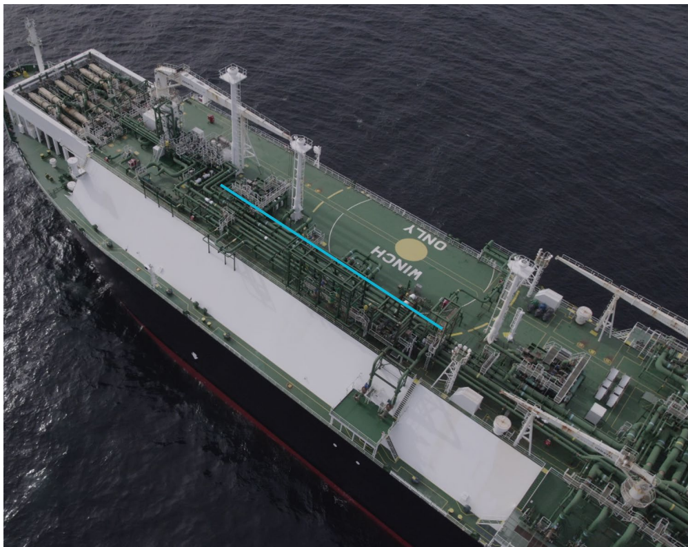
Figura 19 - Fotografia FSRU Tundra – linee di ricircolo serbatoi GNL
