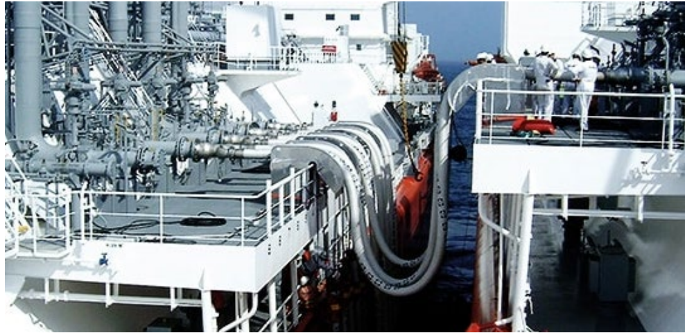
Figura 39 – Tipico collegamento STS per trasferimento GNL
