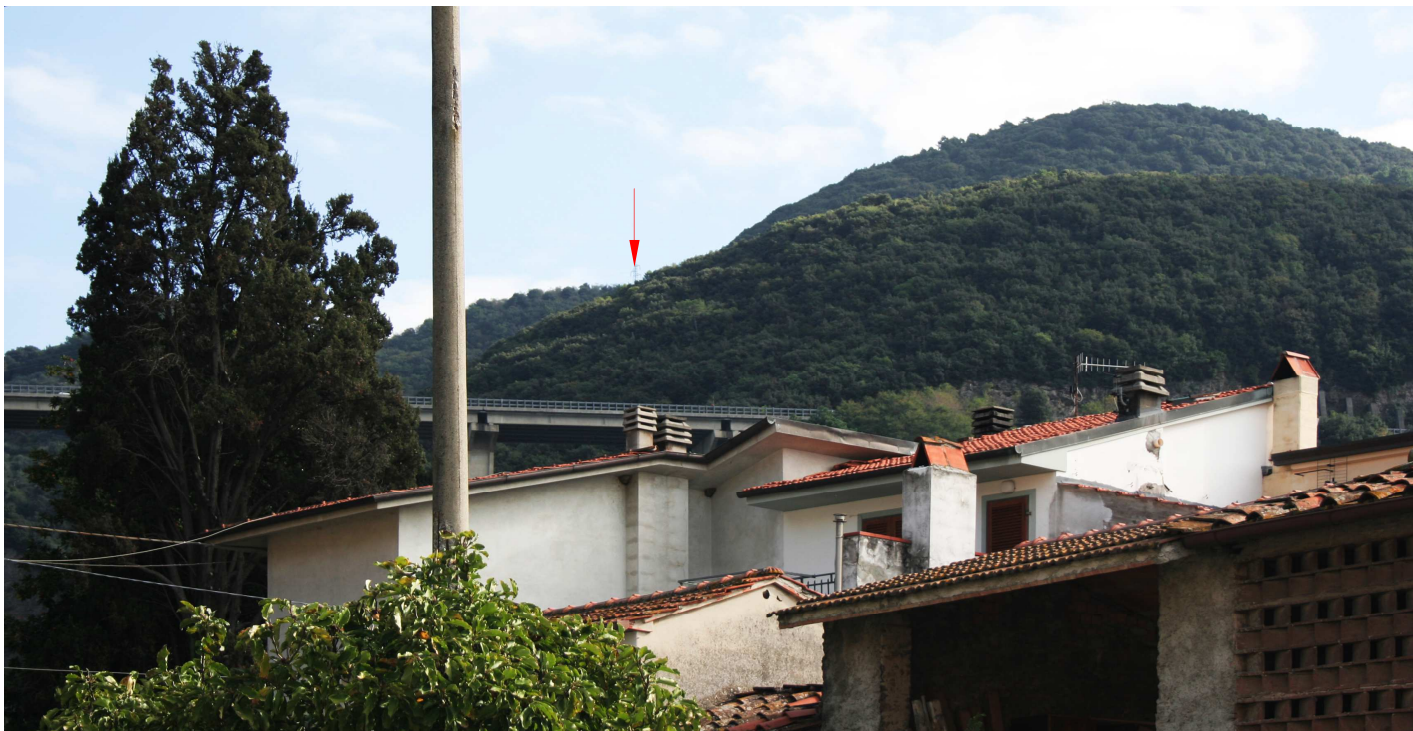
Foto 18: Vista dalla Chiesa SS. Caterina e Prospero verso il monte Comunale. La freccia rossa indica il sostegno n. 21 della linea 132 kV in demolizione.
