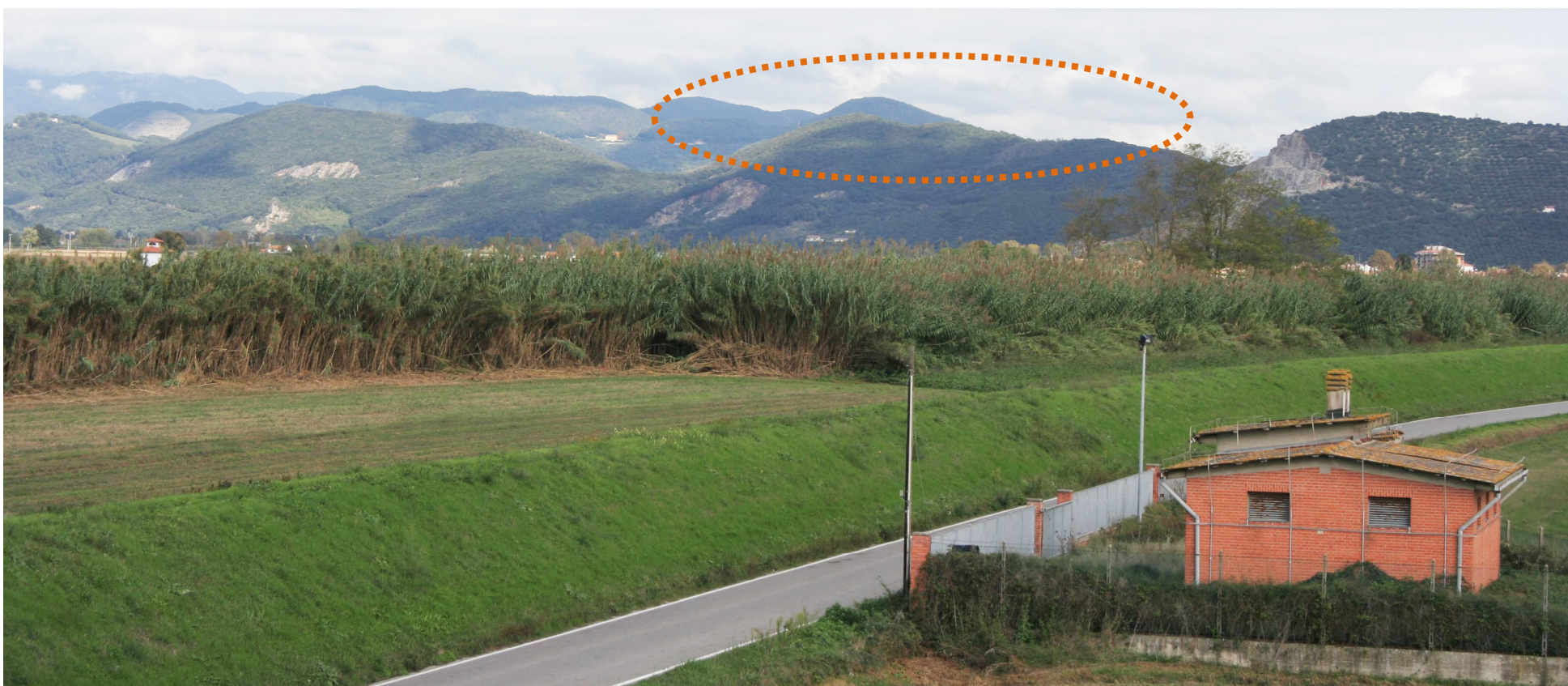
Foto 2: Vista dall'Autostrada A12 Genova-Rosignano, in corrispondenza del ponte sul fiume Serchio. Al centro è evidenziato il rilievo (monte Bozzi) sul cui versante est (opposto rispetto al punto fotografico), in prossimità della linea di displuvio, è prevista la realizzazione in parallelo dei tracciati 132 e 380 kV tra la stazione elettrica di Lucca Ovest (in progetto) e la cabina primaria di Filettole.
