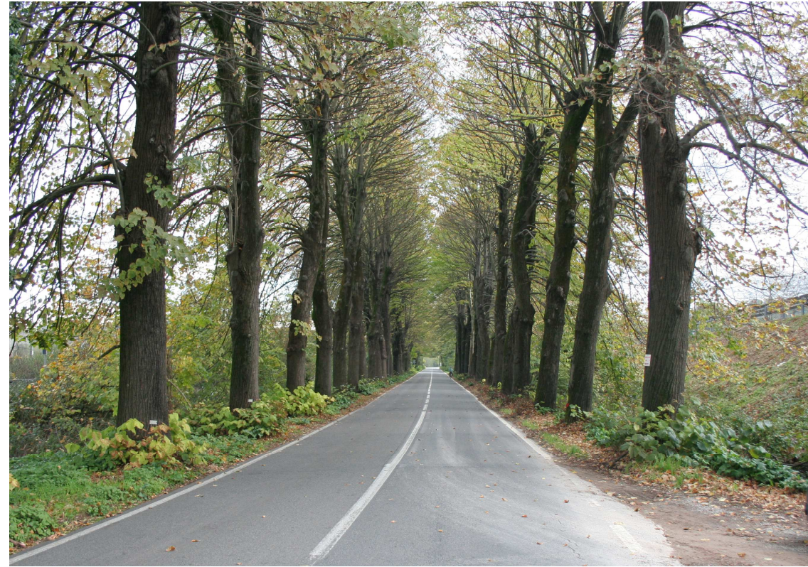
Foto 50: Vista della S.S. 12 nei pressi di Villa Poggio Luce, nella zona di attraversamento della catenaria della nuova linea 380kV tratto sud, tra i sostegni n. 11 e 12. Il viale alberato consente di mitigare l'impatto visuale degli attraversamenti aerei.
