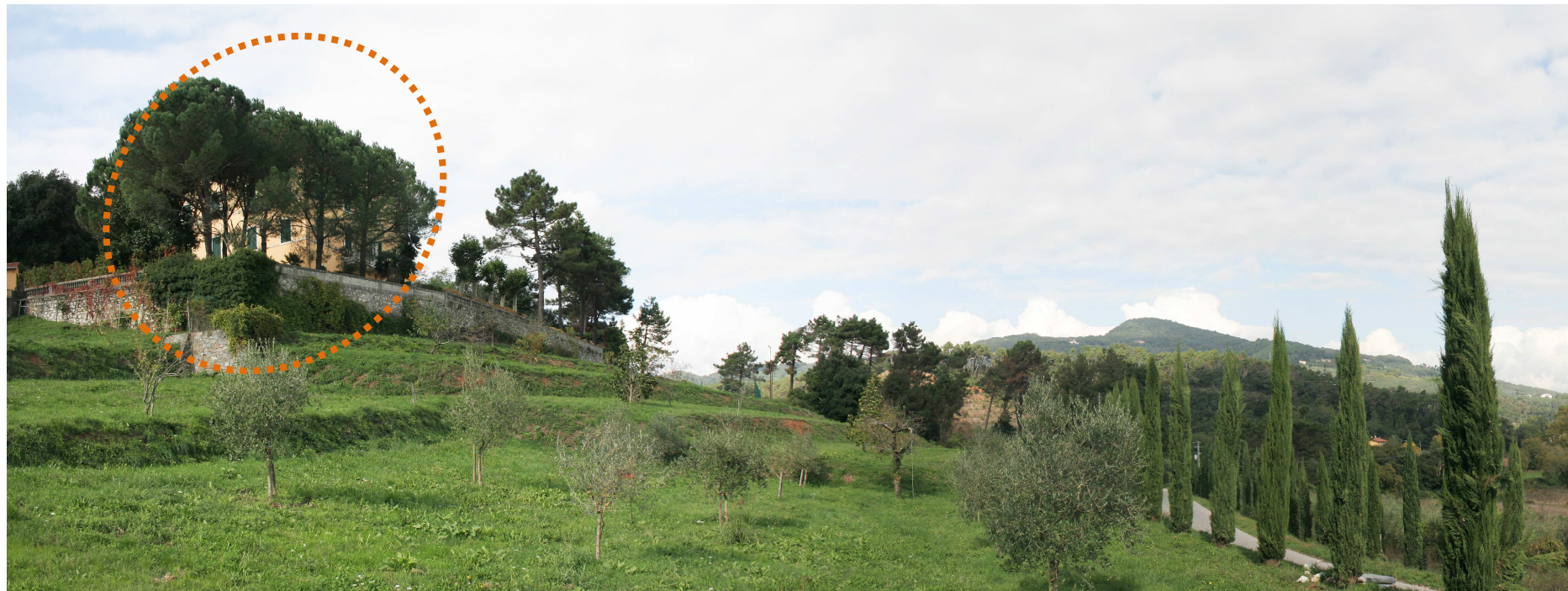
Foto 66: Vista in località C. Nuova verso la S.E. Lucca Ovest in progetto, localizzata nell'ex area di cava in località A Batano. In arancione è indicata Villa Casanova, segnalata dal quadro conoscitivo del PTCP2010 di Lucca come Villa Storica.
