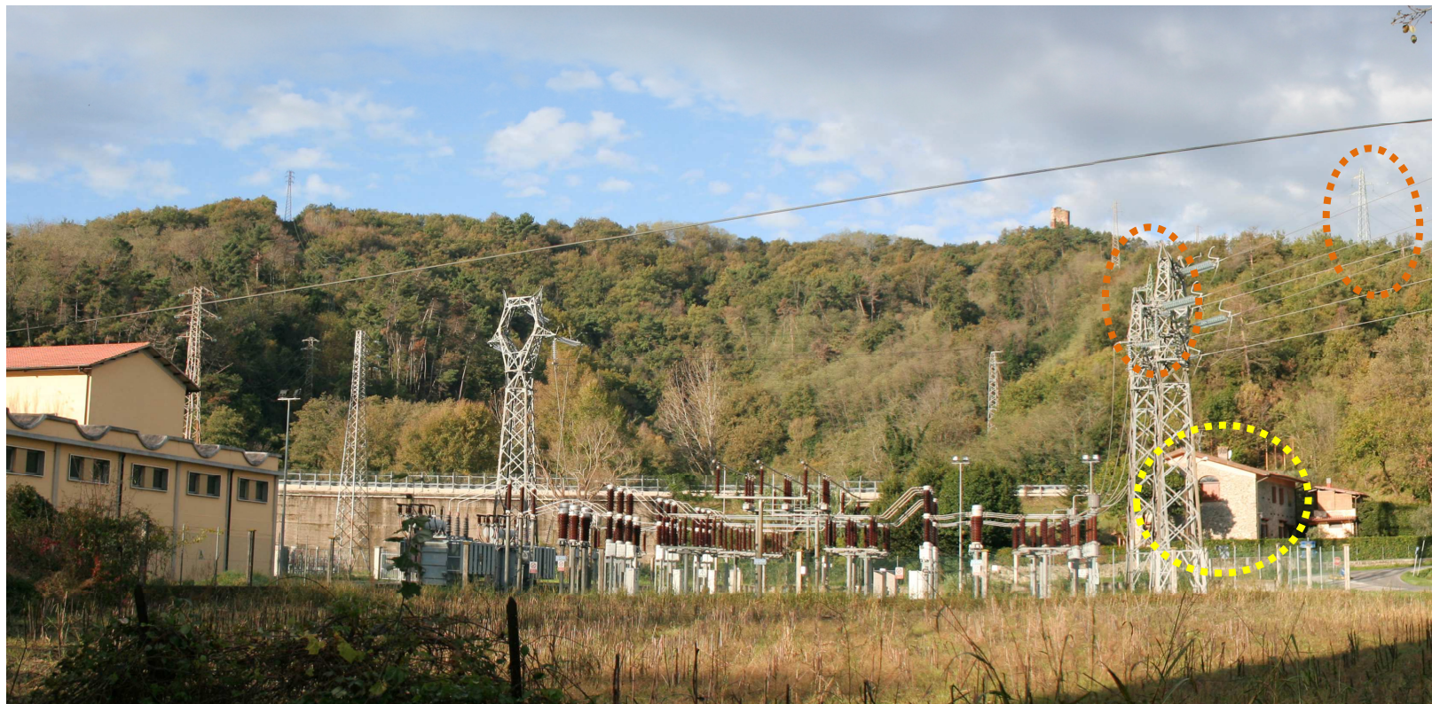
Foto 56: Vista della C.P. Filettole da est. In arancione sono indicati i sostegni n.1 e n.2 della linea 132kV in demolizione, in giallo l'abitazione nei pressi della C.P. In secondo piano, sul profilo collinare, è riconoscibile la Torre Segata.
