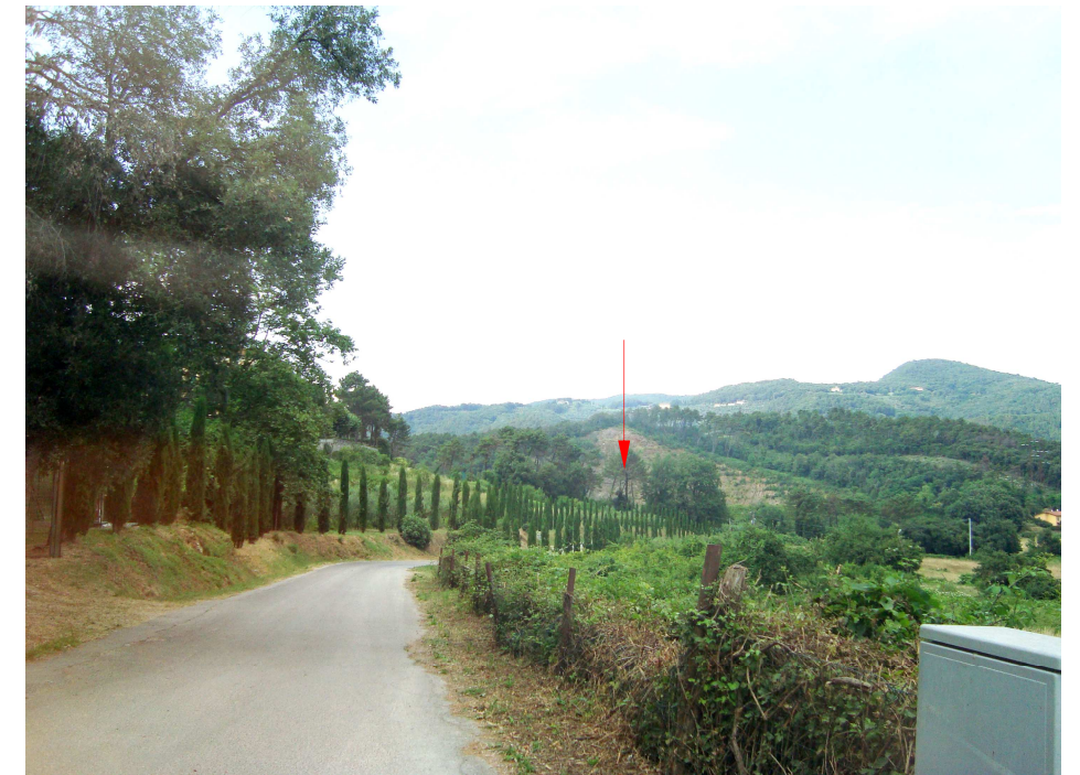
Foto 67: Vista da via di Casanova verso l'ex area di cava dove il progetto prevede la realizzazione della S.E. Lucca Ovest (indicata con la freccia rossa).
