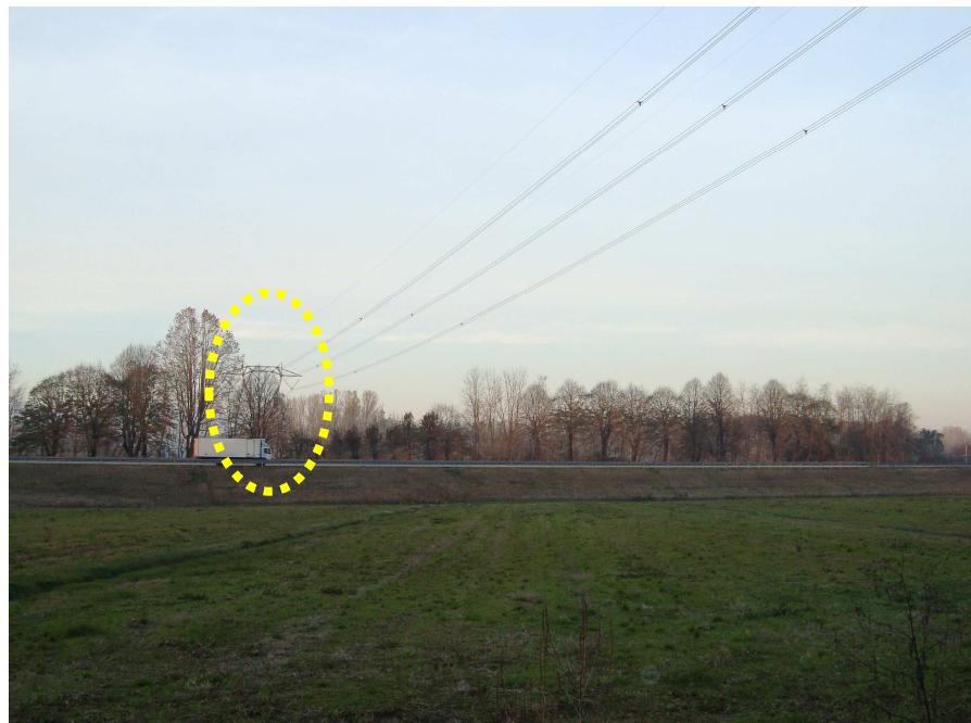
Foto 52: Area agricola a nord di Villa Poggio Luce. In primo piano è visibile l'autostrada A11 Firenze Mare. In giallo è indicato il sostegno n.121 della linea 380 kV in demolizione.
