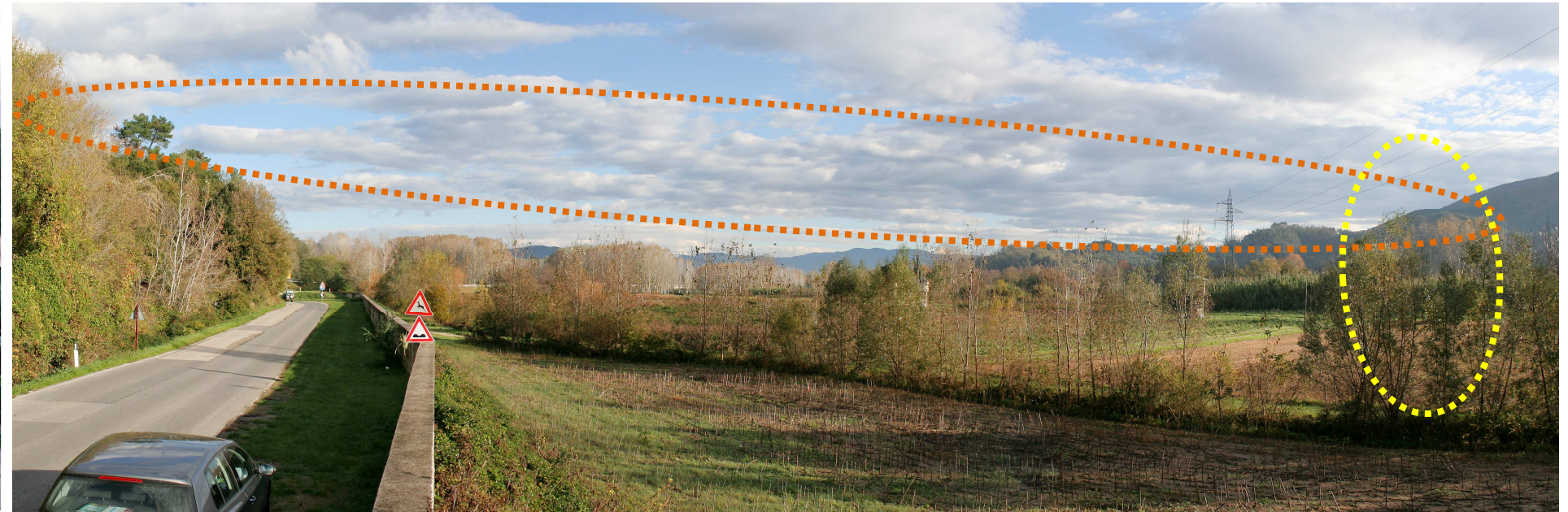
Foto 55: Vista in località Filettole in direzione nord-est. In arancione è indicato attraversamento della catenaria della Linea 132kV DT presso strada del Lungomonte Pisano. In giallo è indicata approssimativamente la posizione del sostegno n.12 in progetto.
