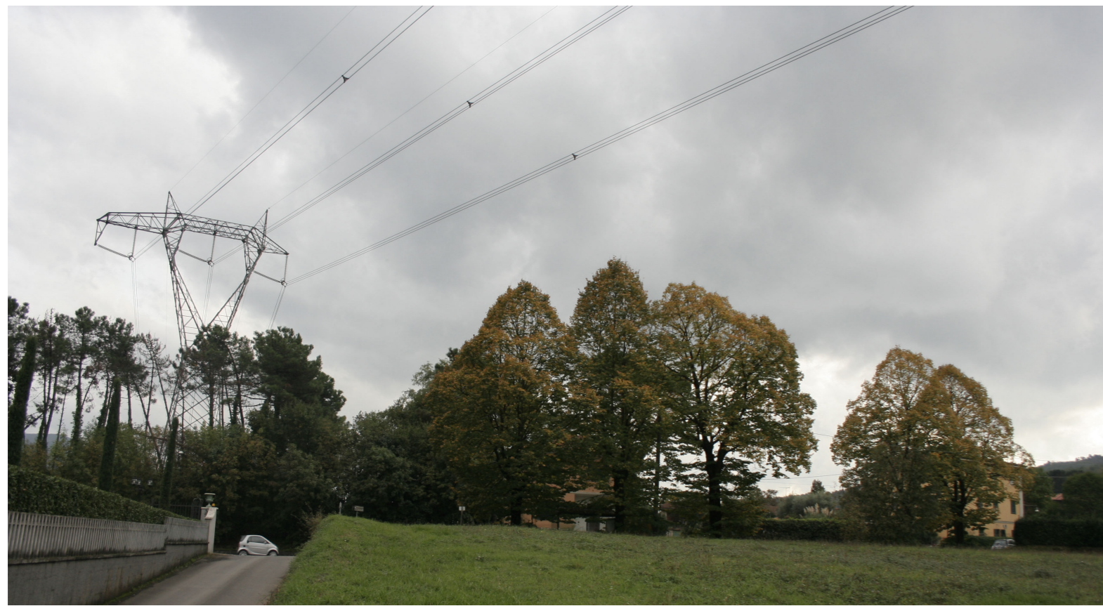
Foto 4: Stato attuale. Vista in località Maggiano del sostegno n.114 della linea 380 kV in demolizione. Il sostegno attuale è collocato in prossimità con le abitazioni residenziali.
