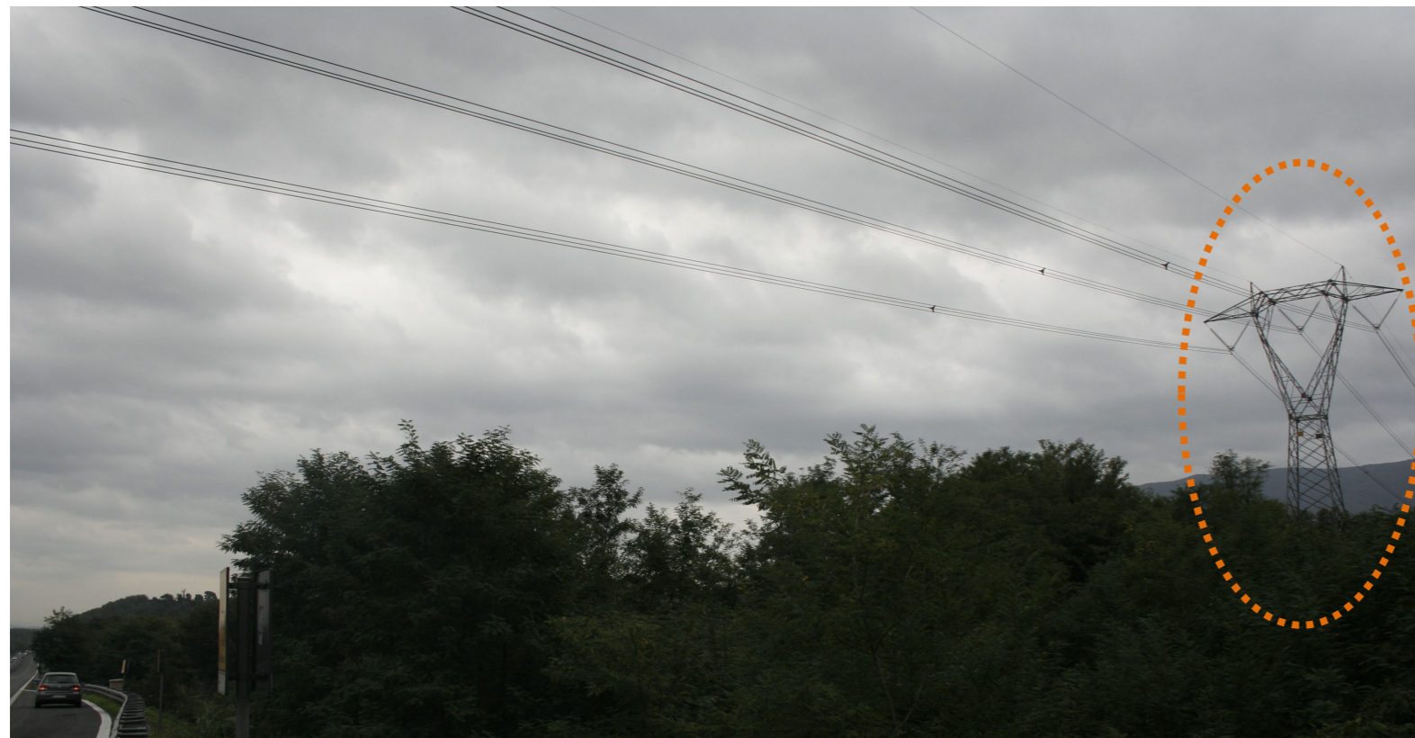
Foto 2: Stato attuale. Vista dal punto di attraversamento dell'Autostrada Bretella Lucca-Viareggio della linea in demolizione 380 kV . In arancione è evidenziato il sostegno n. 115 .
