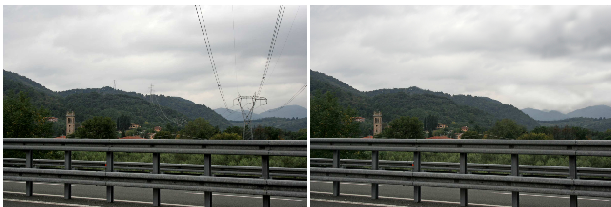
Figura 4.2-2: Interferenza della linea 380kV con l'Autostrada A11 (Bretella Lucca-Viareggio) in prossimità dell'abitato di Maggiano. Stato attuale (sinistra) e in seguito alla rimozione della linea (destra)
