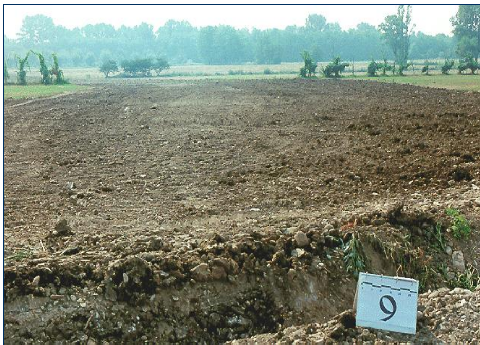
Foto 5/2– Livellamento terreno vegetale
