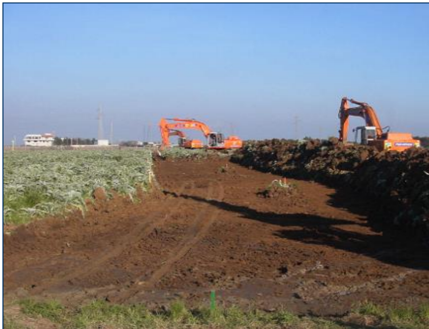
Foto 5/1 – Apertura area di passaggio scotico ed accantonamento terreno vegetale “humus”
