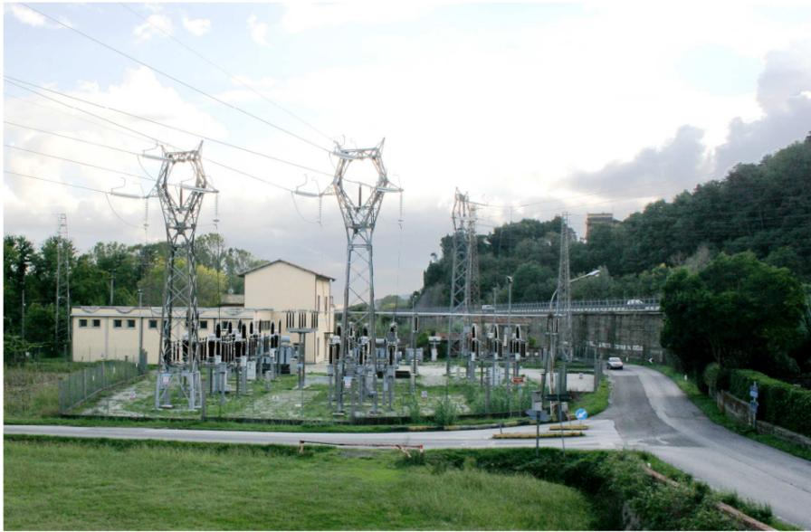
**Foto 54:** Vista della C.P. Filettole e della strada del Lungomonte Pisano. Il progetto prevede la demolizione del tracciato 132 kV in ingresso alla stazione.
