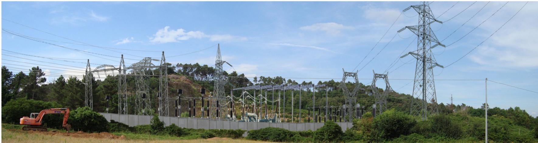
**Foto 14a:** Stato di progetto, in assenza di interventi di mitigazione paesaggistico-ambientale. Si può notare a destra l'ingresso della linea 132 kV in dt; a sinistra l'ingresso della linea 380 kV in st; in posizione retrostante, verso il fronte di cava, si notano i primi due tralicci della linea 132 kV in st. In primo piano la recinzione perimetrale in calcestruzzo armato.
