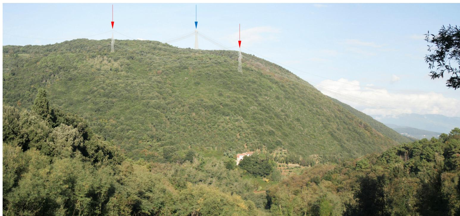
**Foto 11:** Stato di progetto. Le frecce rosse indicano la posizione dei sostegni n.13 e n.14 della linea 132kV ST in progetto. In prossimità del crinale si colloca il sostegno n.12 della linea 380 kV tratto nord in progetto evidenziato dalla freccia blu.
