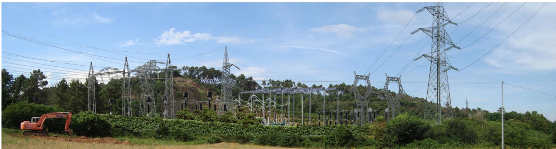
**Foto 14b:** Stato di progetto, in presenza degli interventi di inserimento paesaggistico-ambientale. Si può notare come la recinzione venga mascherata da una siepe perimetrale sempreverde. Le fasce arboreo-arbustive realizzate per il mascheramento della SE permetteranno di limitare la percezione visiva degli interventi di nuova realizzazione dalla località "A Batano" e da Via di Casanova.
