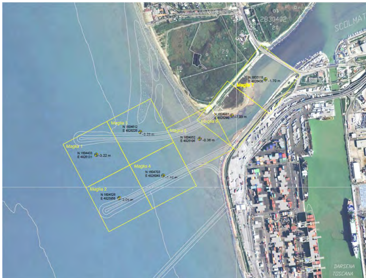
Figura 3-4 - Caratterizzazioni eseguite nell'ambito della realizzazione dell'armatura di foce (2014)
