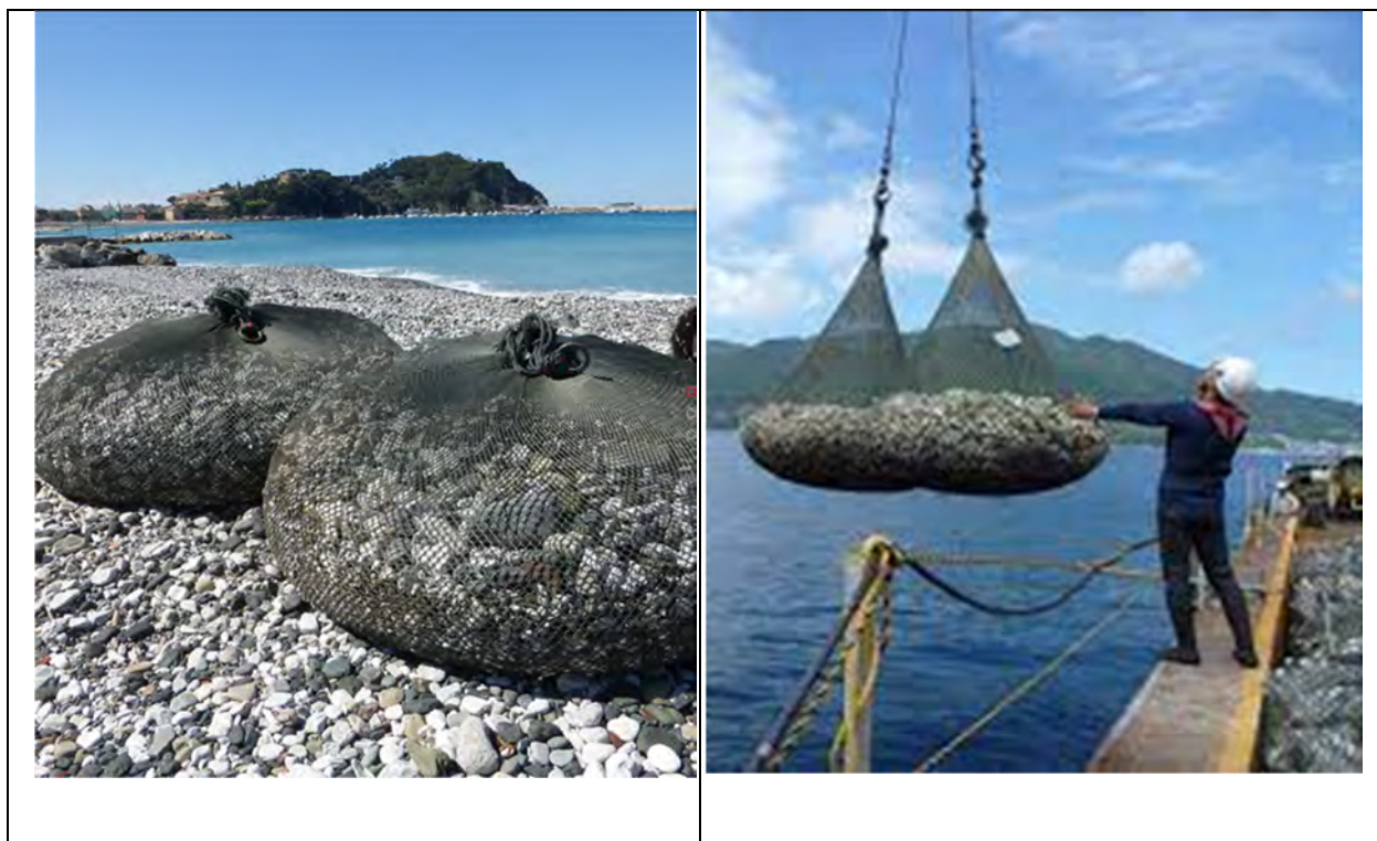
Figura 2-4 - Sacconi zavorrati tipo filter unit in doppia rete di poliestere riempiti di pietrame
