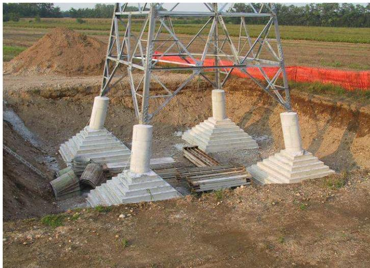
Poiché le fondazioni unificate sono utilizzabili solo su terreni normali di buona e media consistenza, per sostegni posizionati su terreni con scarse caratteristiche geomeccaniche, su terreni instabili o su terreni allagabili, sono progettate fondazioni speciali (pali trivellati, micropali, tiranti in roccia), sulla base di apposite indagini geotecniche.
