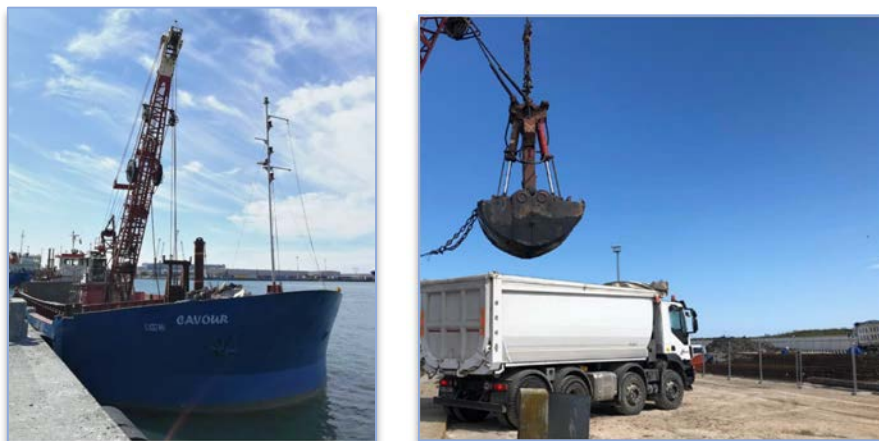
Figura 5-3 – trasporto dei sedimenti dragati in classe di qualità D con “GH/GHD – Grab Hopper Dredger” dalle vasche di accumulo intermedie previste in fase esecutiva ai bacini impermeabilizzati.
