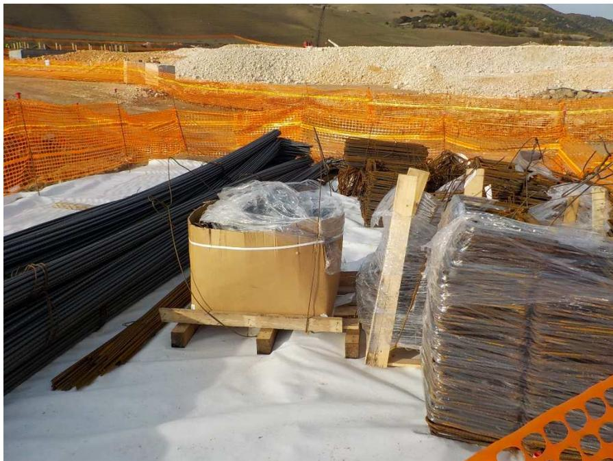
**Figura 12 - Allestimento area deposito materiali ferrosi**
