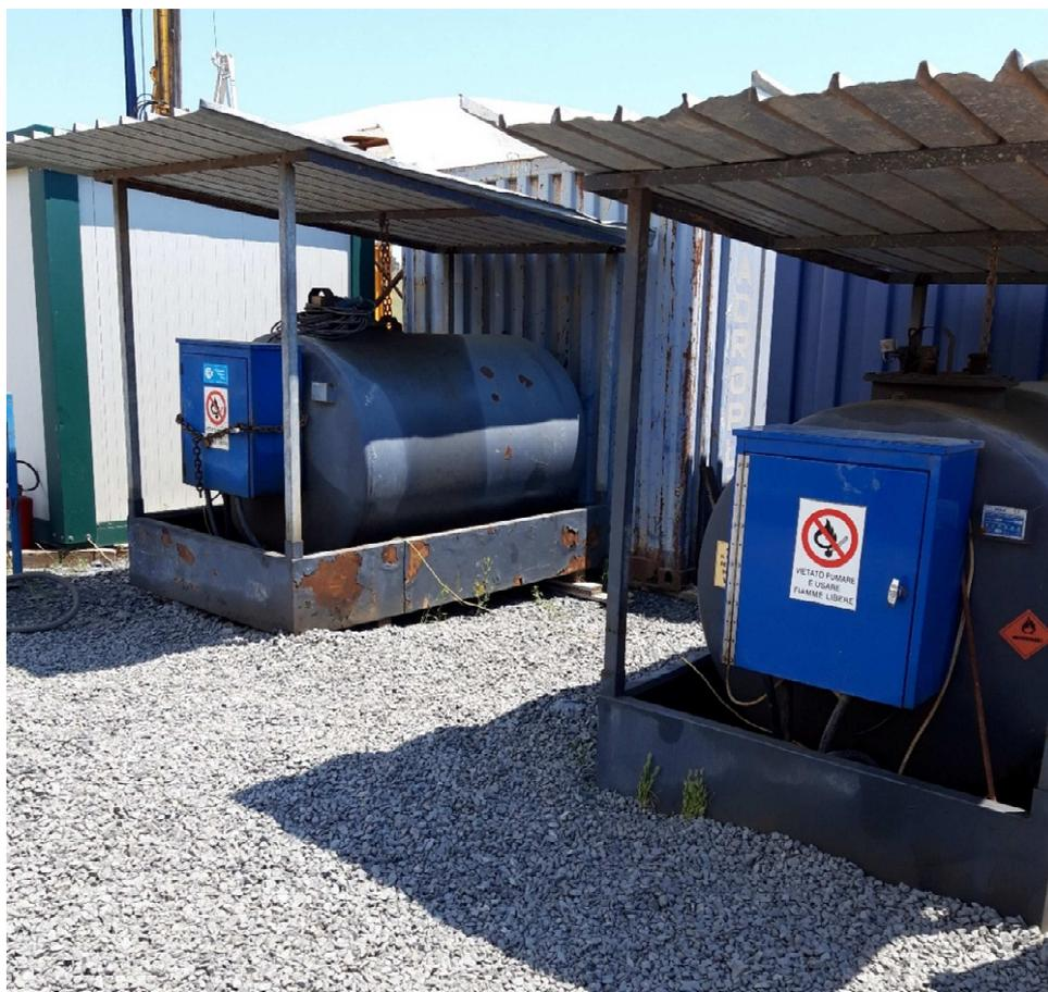
**Figura 19 - Allestimento area rifornimento mezzi su zona non pavimentata**
