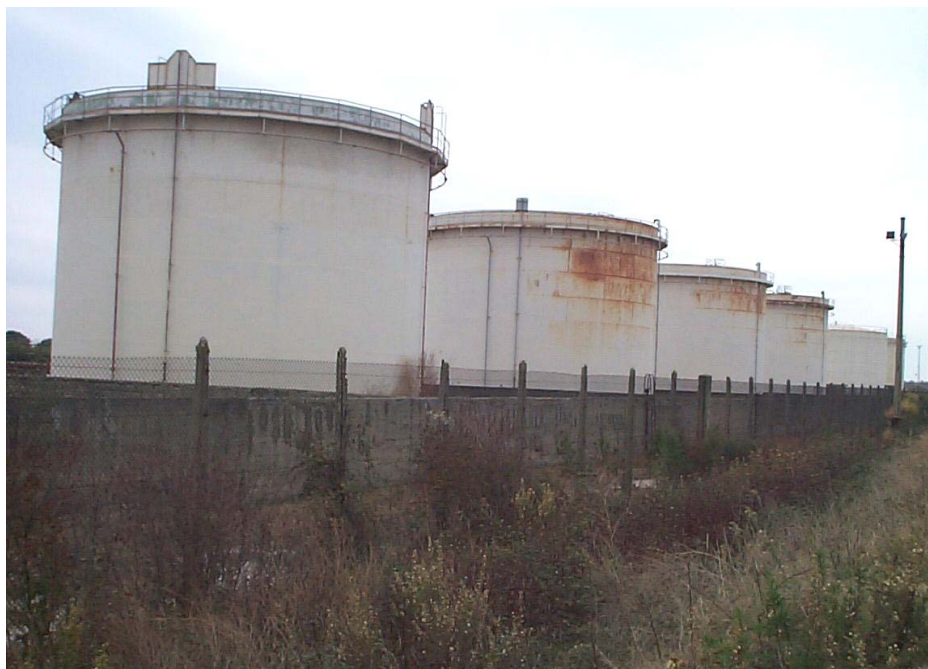
Foto n° 2 - serbatoi "I", "H", "G", "F" ed "E"
