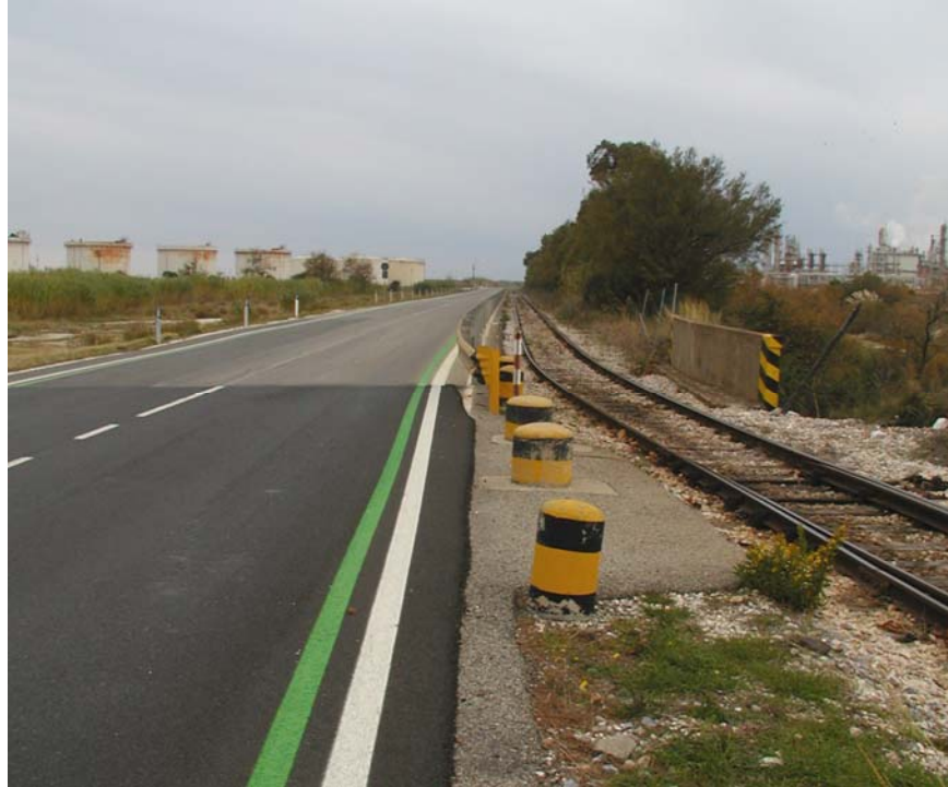
Foto n° 6 - Situazione attuale della strada e ferrovia interna
