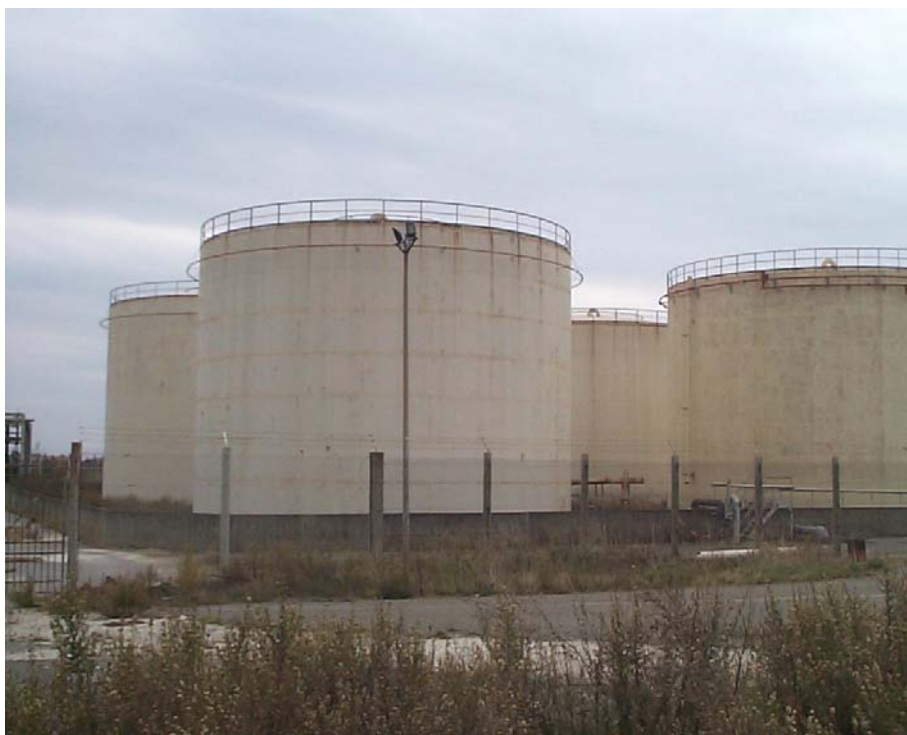
Foto n° 4 - serbatoi "A", "B", "C" e "D"
