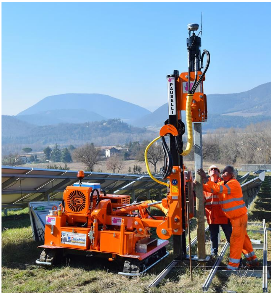
Figura 39-infissione dei piedi della struttura monoassiale tramite macchina battipalo
