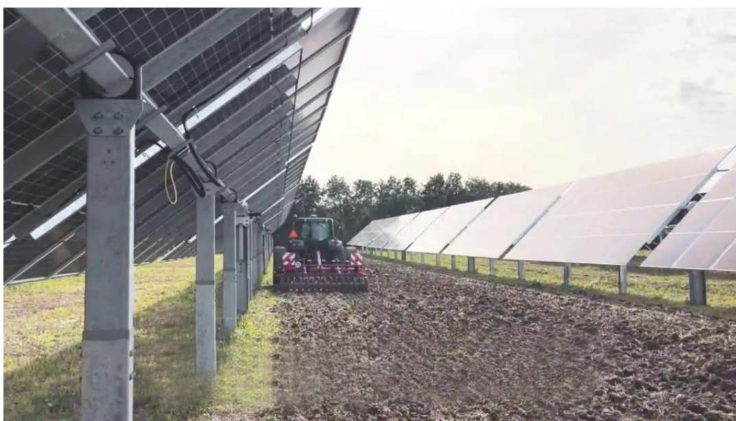
Figura 42-Tracker disposti con inclinazione massima durante una lavorazione tipo
