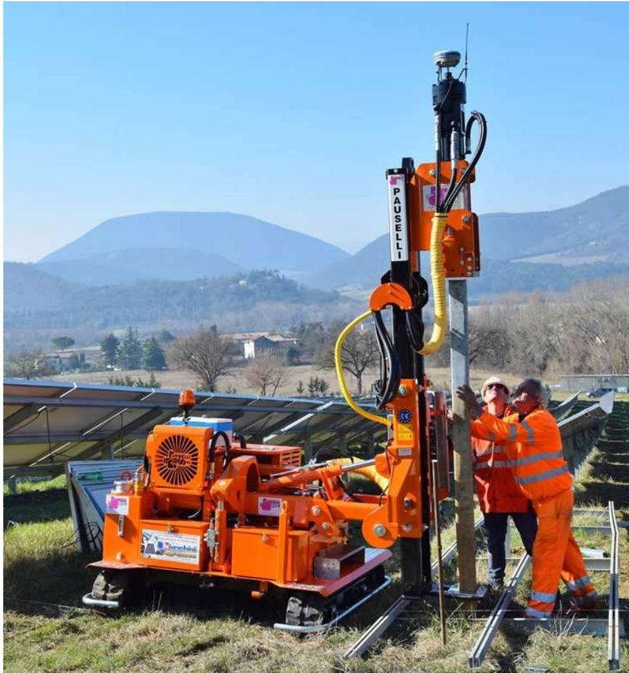
Figura 2 -infissione dei piedi della struttura monoassiale tramite macchina battipalo
