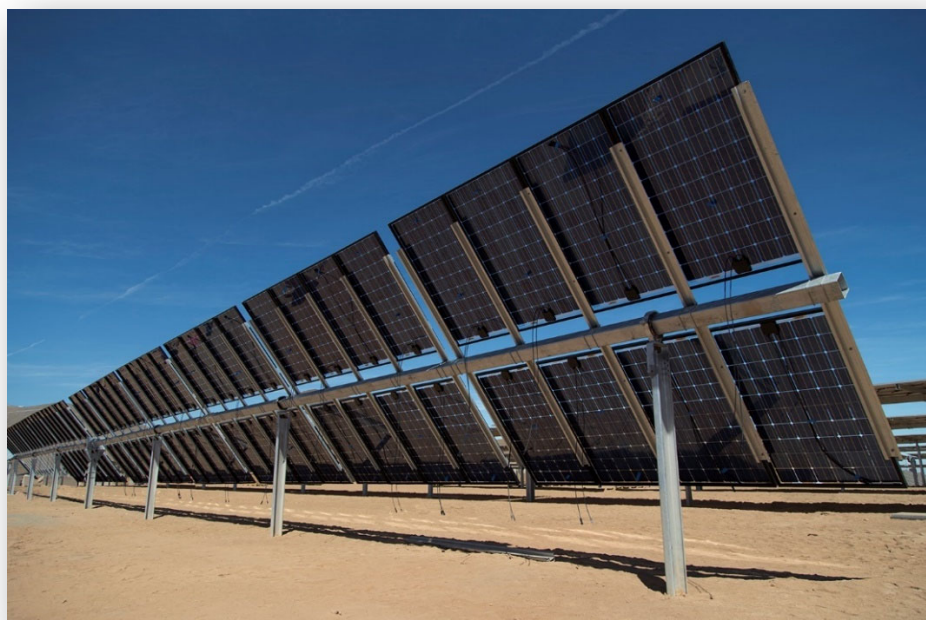
Figura 3 – vista prospettica inseguitore solare monoassiale
