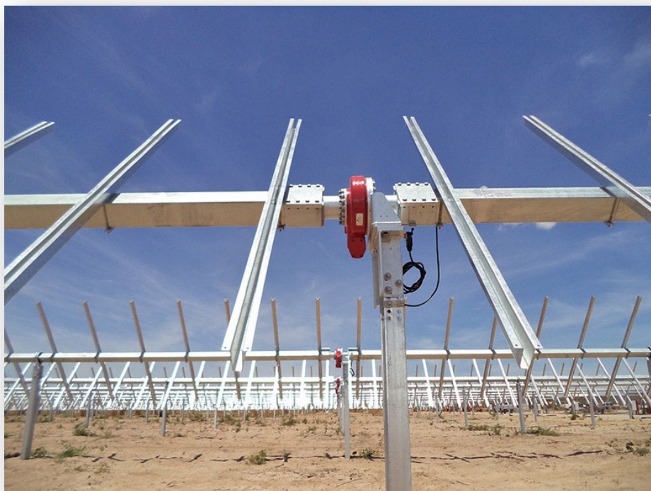
Figura 4 – Struttura dell'inseguitore solare monoassiale
