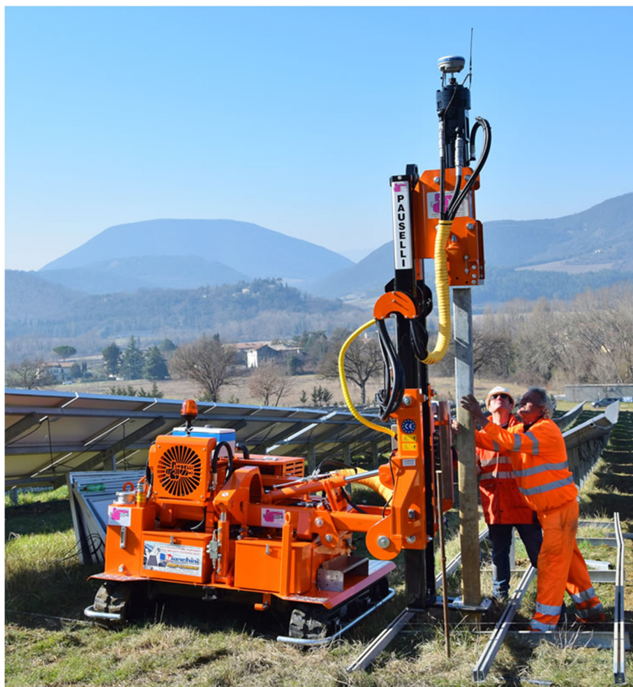
Figura 5 - Infissione dei piedi della struttura monoassiale tramite macchina battipalo
