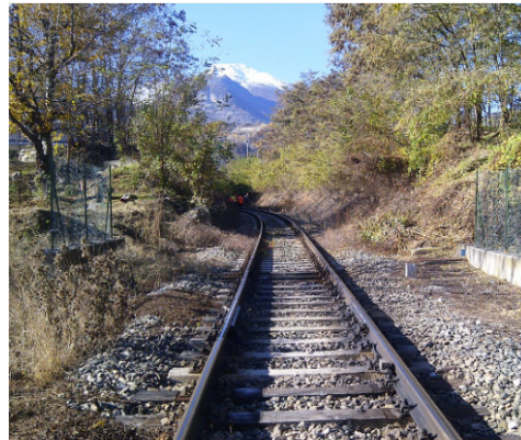
Impianto lubrificazione P.A.L. Italia (Foto: P.A.L. Italia; 2012)
