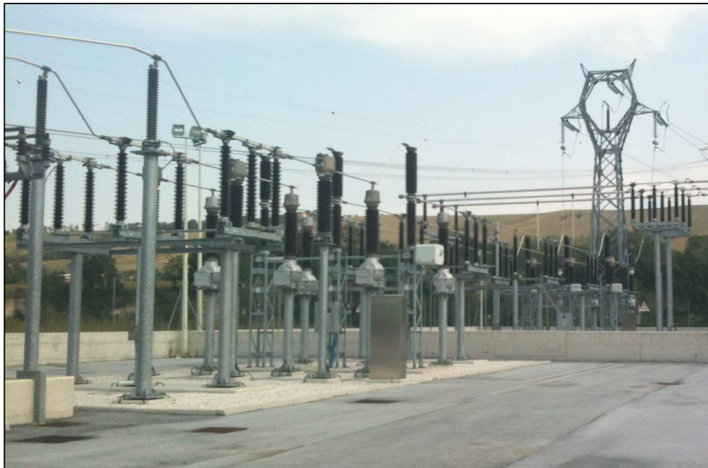
Figura 33: Esempio stallo in Stazione Elettrica
