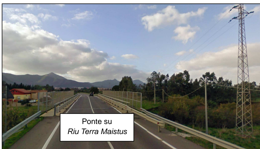
Figura 3: Elettrodoto di Connessione - Attraversamento “Riu Terra Maistus”
