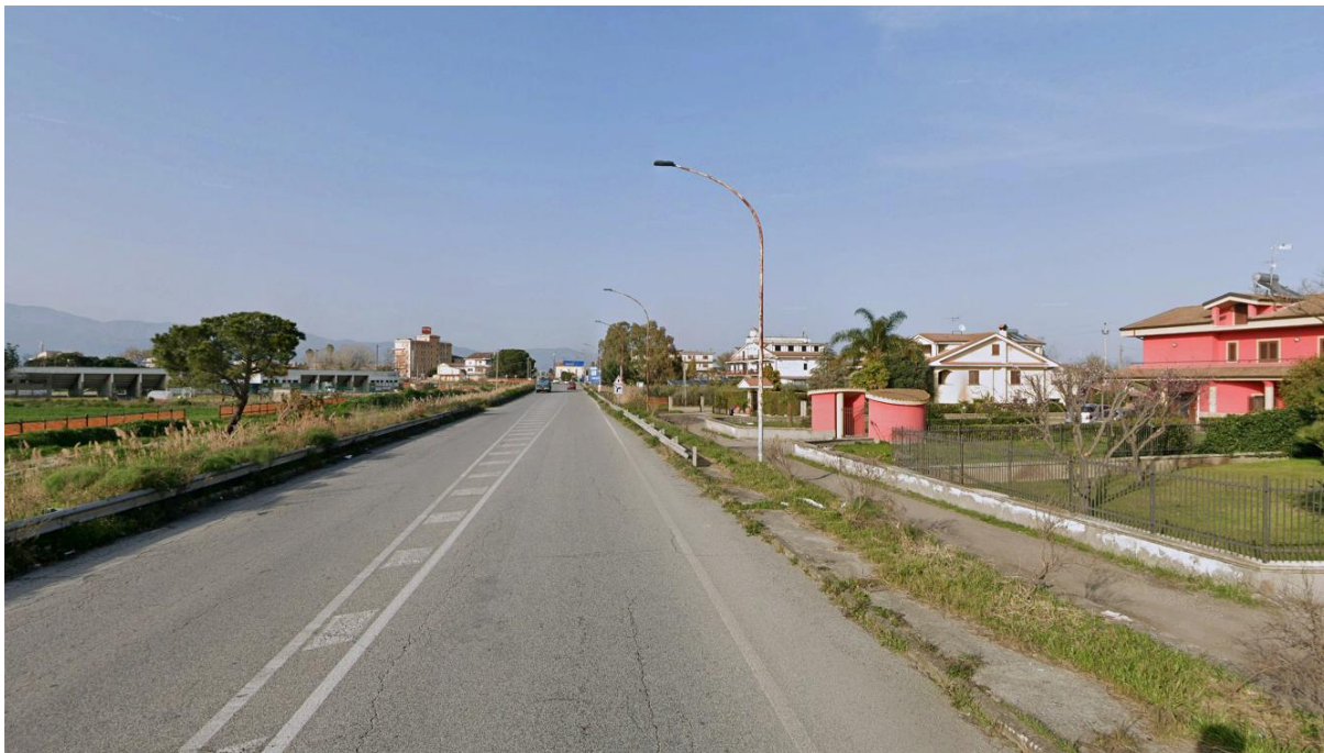
Figura 2 – Vista da sud lungo SS106 Ionica, ante operam , da Relazione paesaggistica
