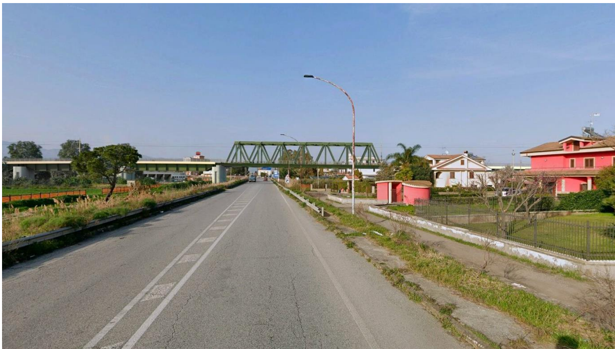
Figura 3 – Vista da sud lungo SS106 Ionica, post operam , da Relazione paesaggistica
