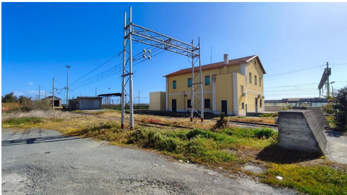
Fig. 7 – Stazione di Sibari, edificio apparato centrale elettrico (ACEI) post operam , Relazione paesaggistica
