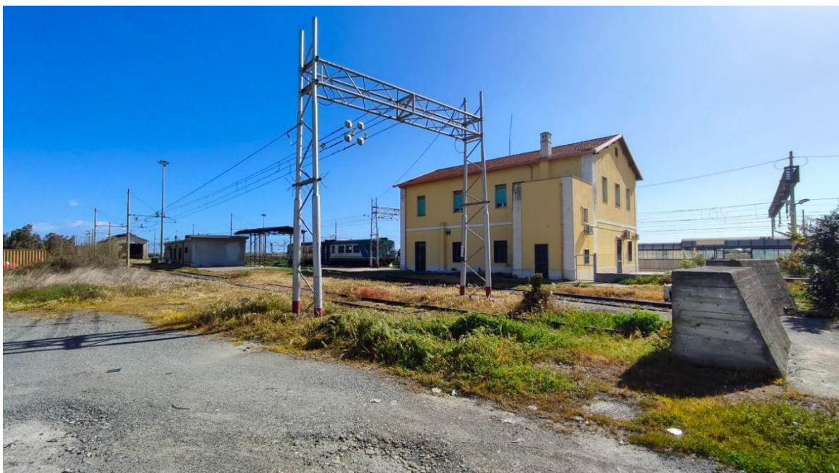
Fig. 6 – Stazione di Sibari, edificio apparato centrale elettrico (ACEI) ante operam , Relazione paesaggistica
