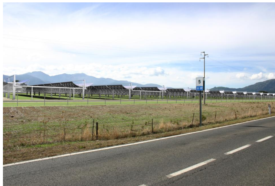
Punto di vista PV 1 – stato modificato, collettori in posizione on-focus
