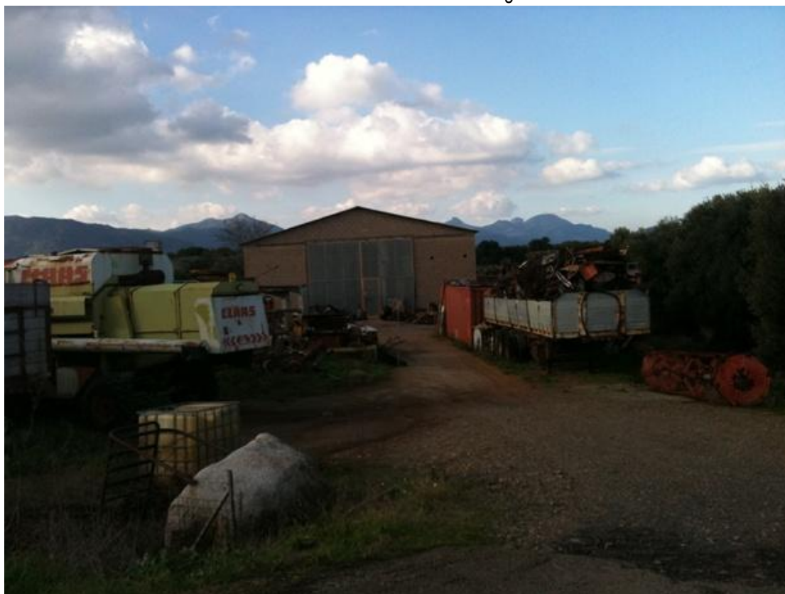
Ricettore n. 16: edificio adibito a magazzino
