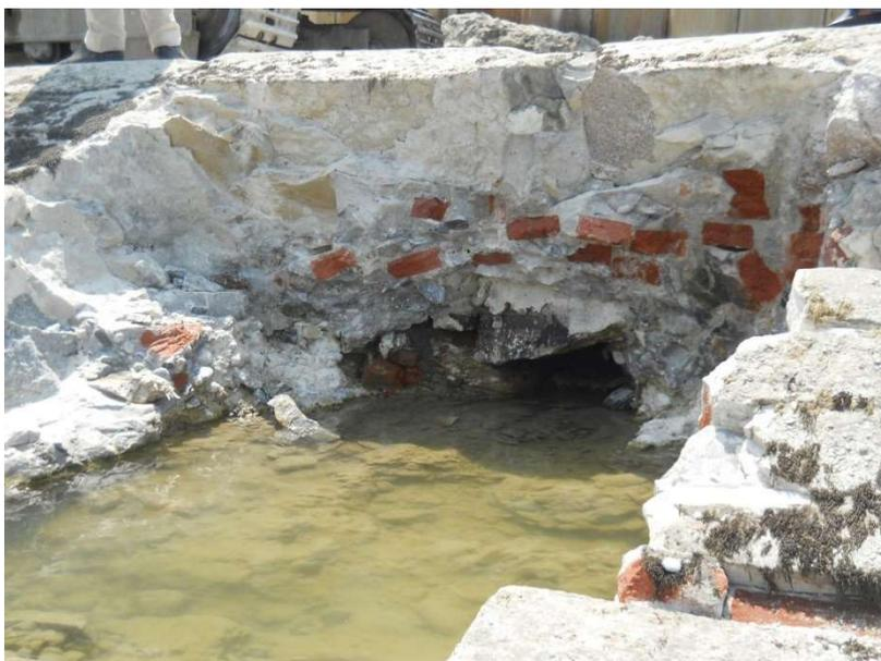
*Figura 6: Dissesto del corpo originario della traversa*
