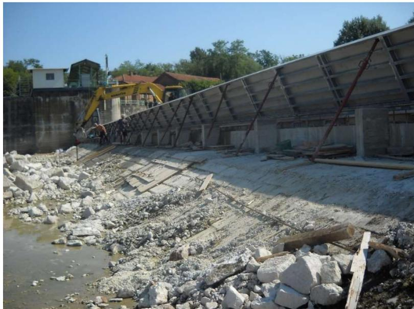
*Figura 33: Particolare lavori di realizzazione sopralzo mobile (2013)*
