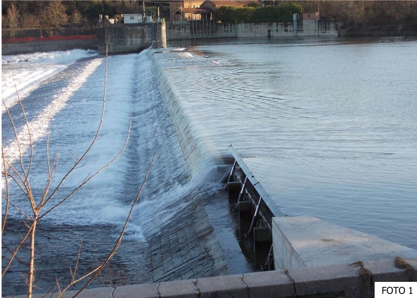
*Figura 47: Vista della traversa Lanza a ciglio mobile dalla sponda sinistra*
