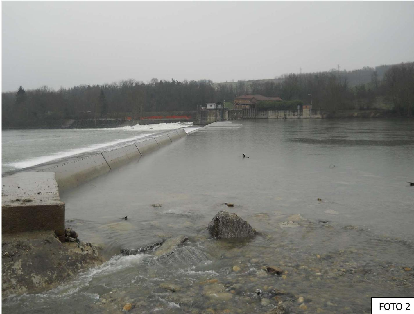
*Figura 48: Vista della traversa Lanza a ciglio mobile dalla sponda sinistra – monte*
