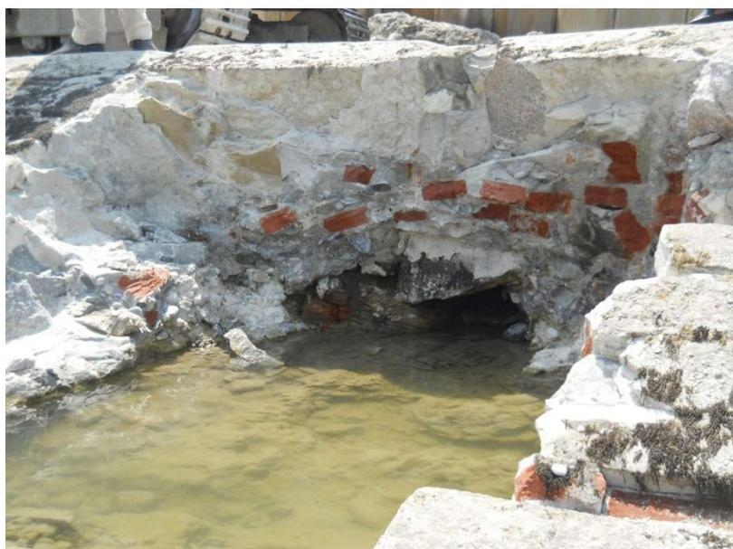
*Figura 32: Dissesto del corpo originario della traversa*
