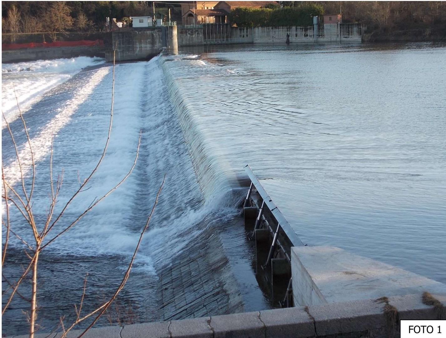
*Figura 35: Vista della traversa Lanza a ciglio mobile dalla sponda sinistra*
