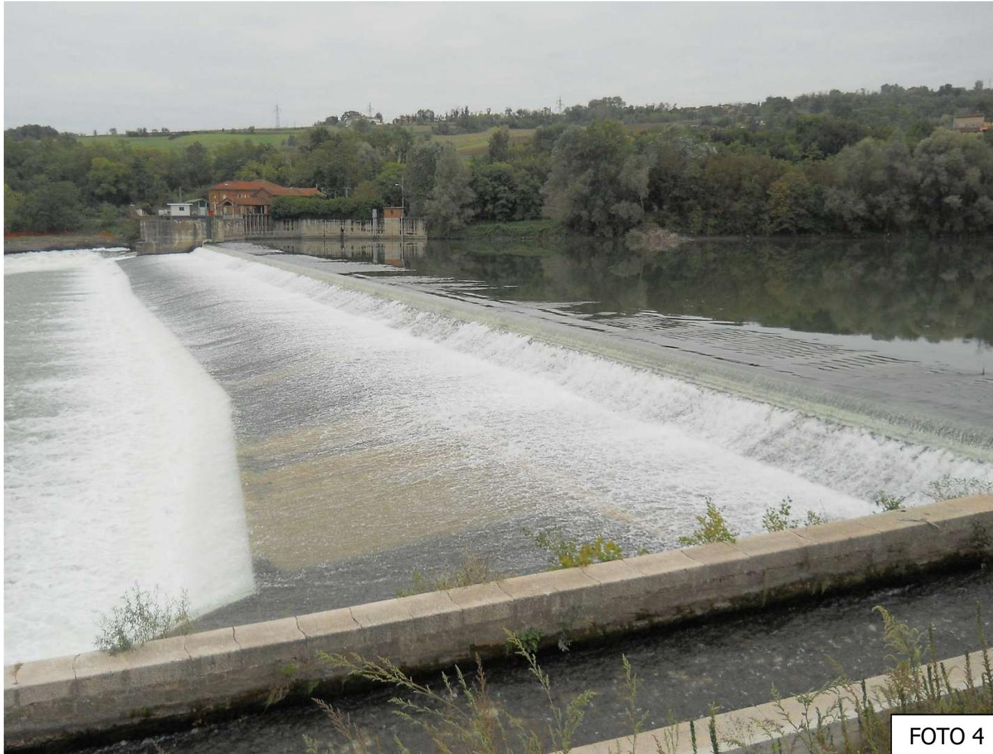
*Figura 50: Vista della traversa Lanza a ciglio mobile – valle (elementi mobili in posizione abbassata)*
