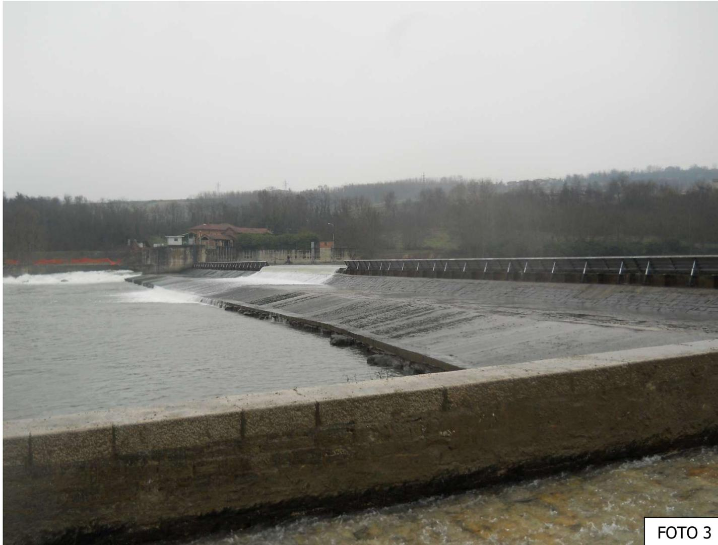
*Figura 49: Vista della traversa Lanza a ciglio mobile dalla sponda sinistra – valle*
