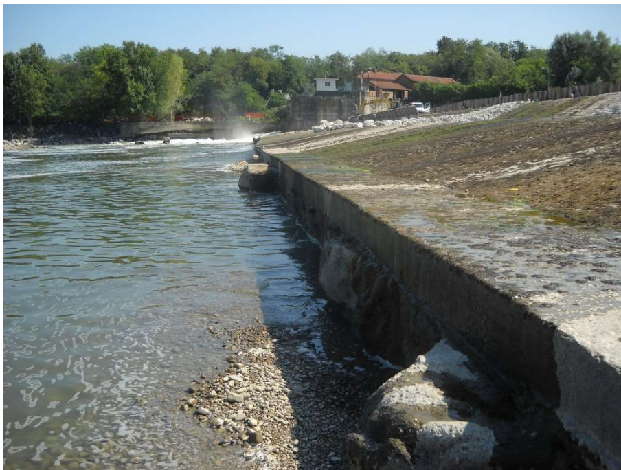
Figura 7: Vista ringrosso di valle e rivestimento in cls (foto 2014)
