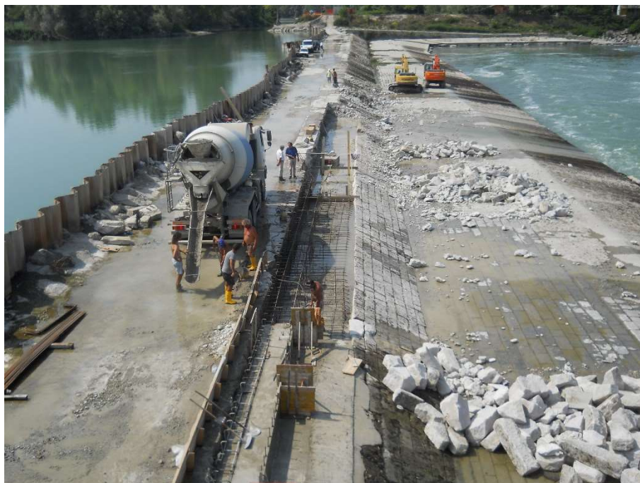
Figura 9: Lavori di realizzazione del sopralzo mobile (2013)
