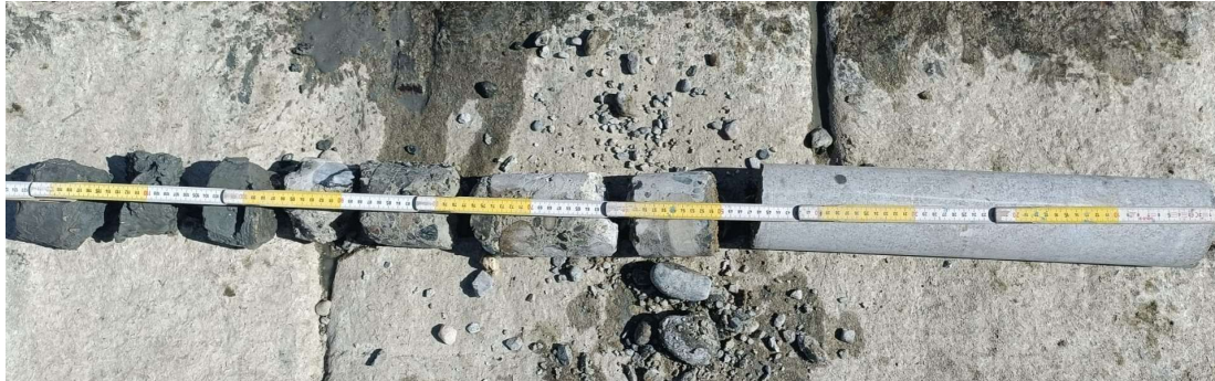
Figura 14: Carota n. 3 con terreno sabbioso argilloso
