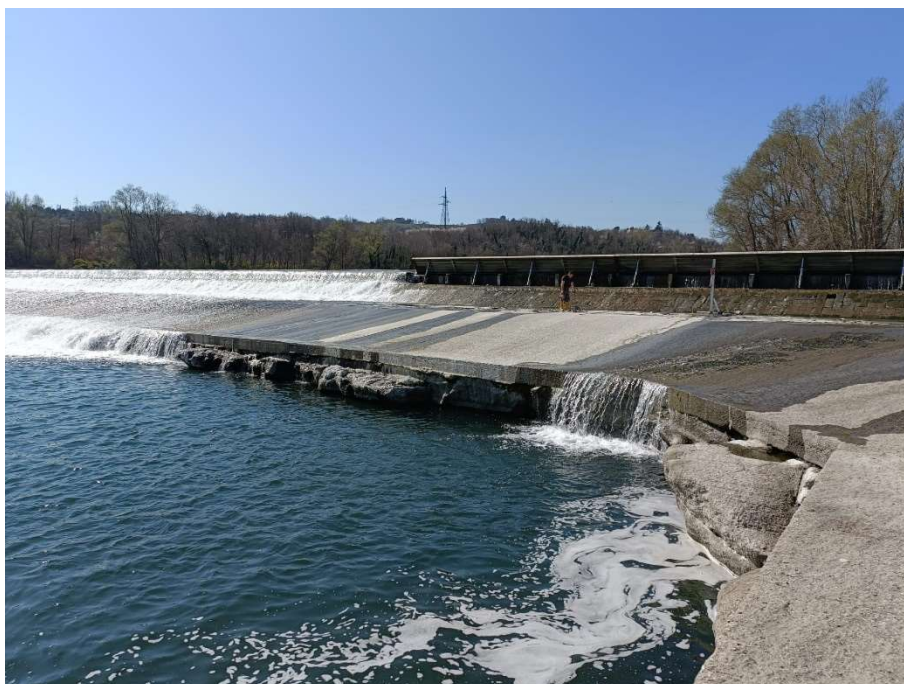
Figura 8: Vista ringrosso di valle e rivestimento in cls (foto 2022)
