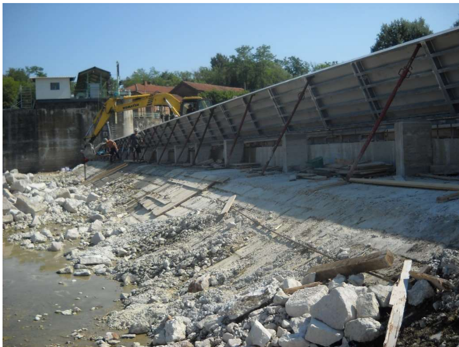
Figura 11: Particolare lavori di realizzazione sopravanzo mobile (2013)
