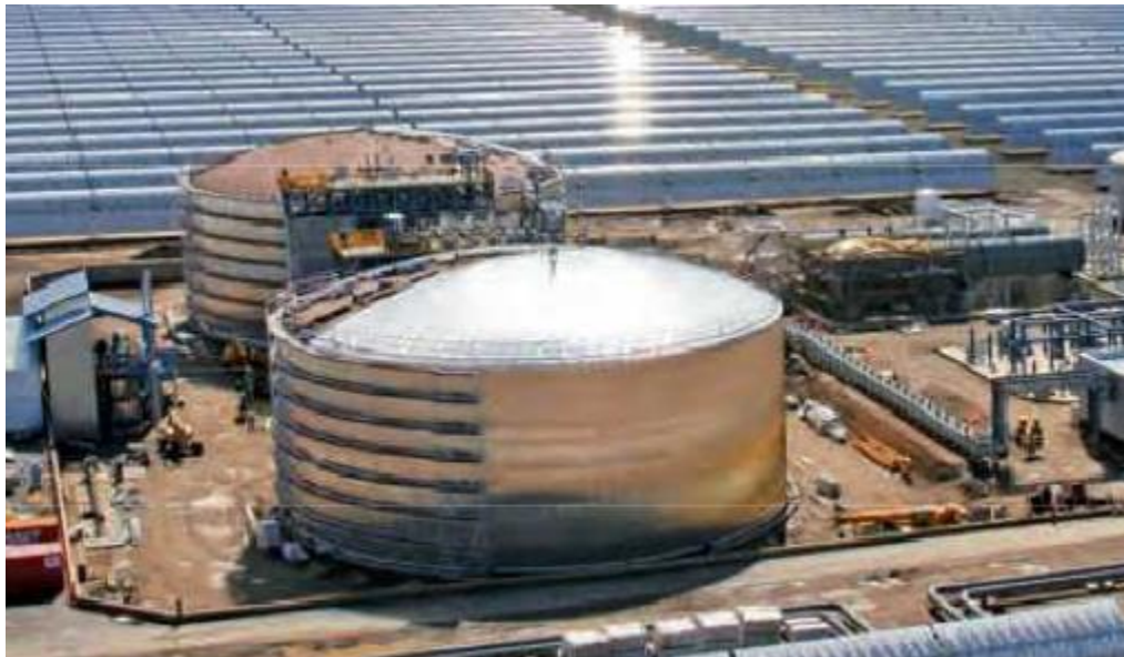
Figura 21. Serbatoi di Accumulo - Esempio
