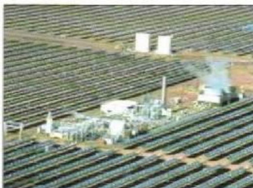
Figura 4. Vista area di uno degli impianti di Kramer Junction
