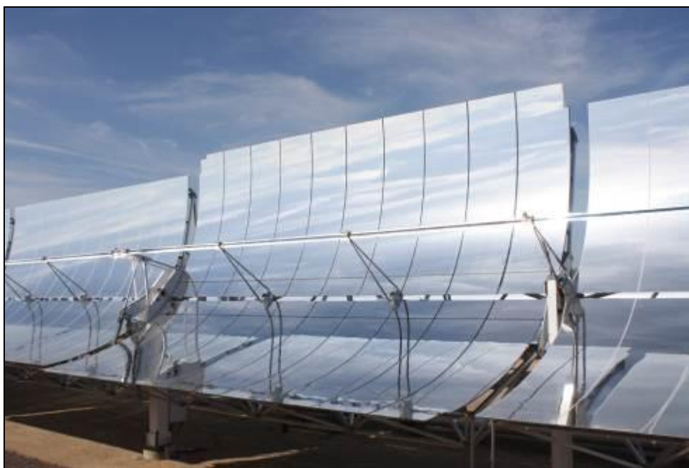
Figura 11. Collettore parabolico LAT 8.0 m - SCE
