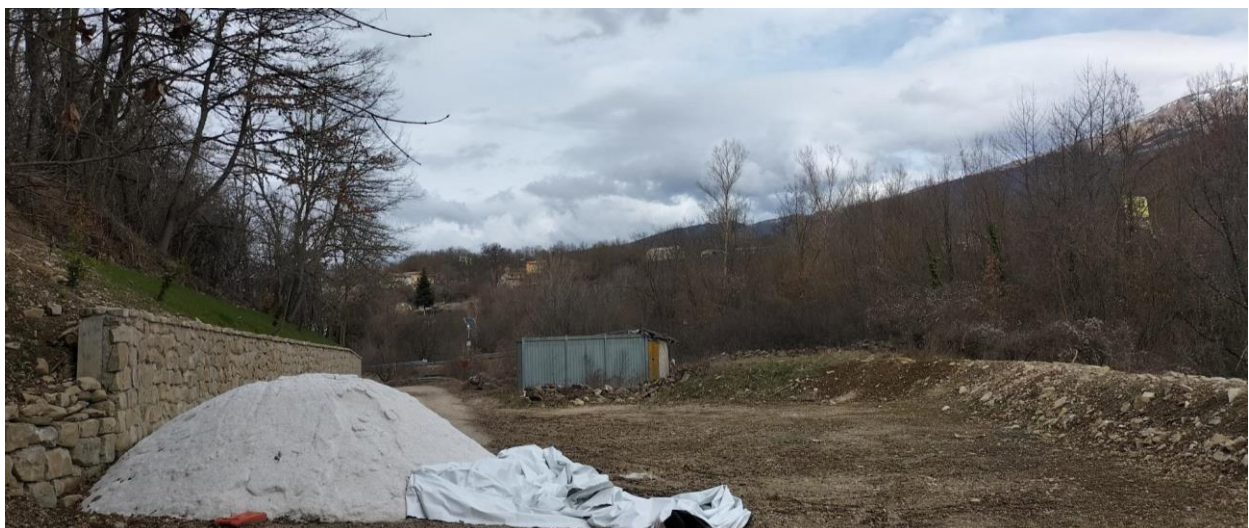
Figura 13. Stato di fatto area logistica CB01
