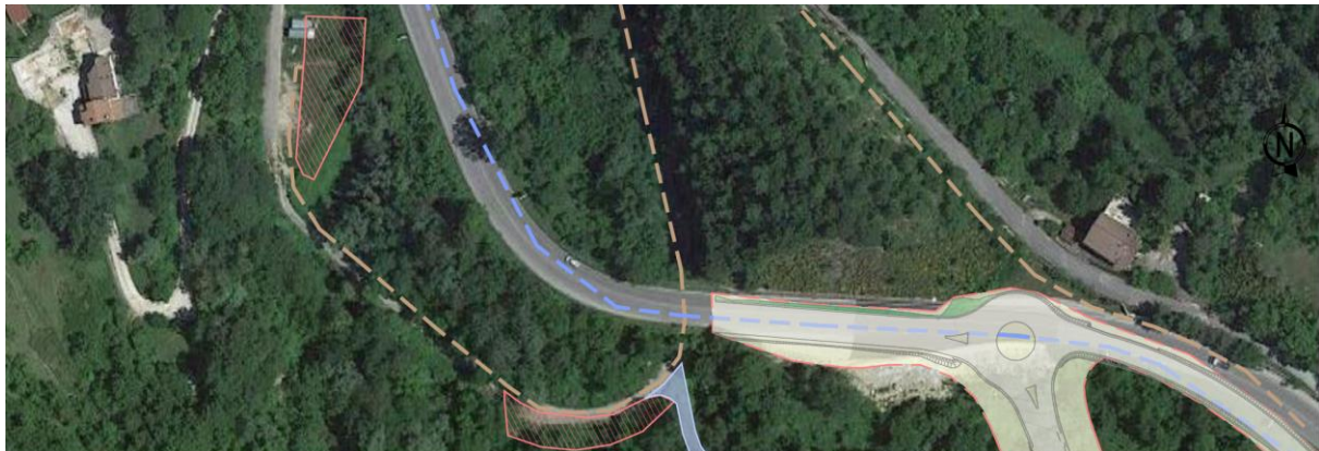
Figura 13. Ubicazione dell'area del cantiere base CB01
