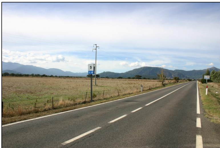
Figura 7: Area di progetto - Presa fotografica da SS 197
