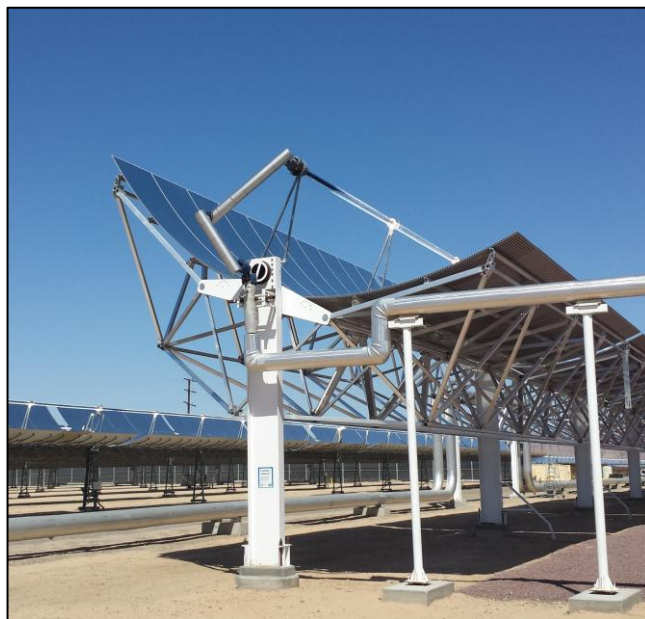
Figura 16: Collettore parabolico lineare LAT 8.0
