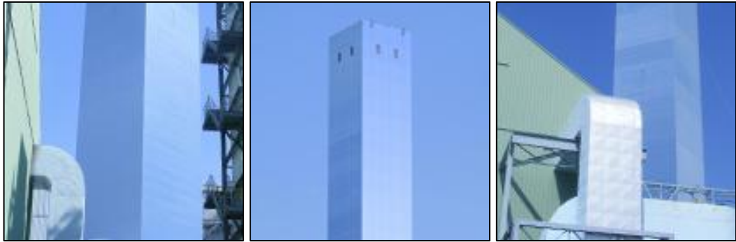
Figura 42: Esempio colorazione camino termovalorizzatore A2A Brescia
