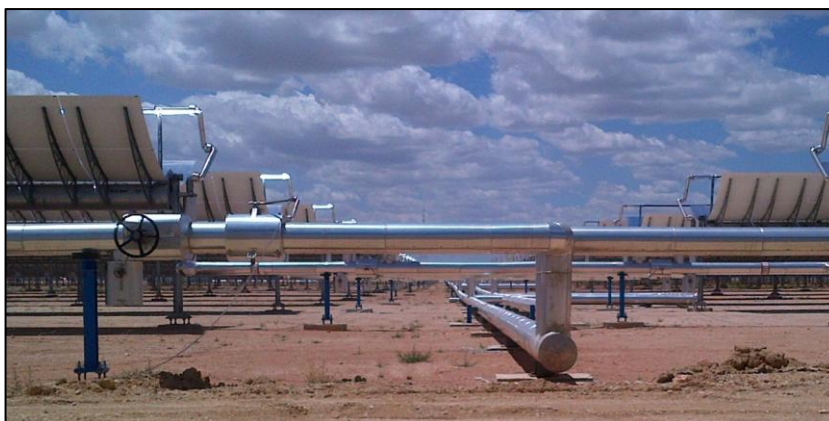
Figura 54: Esempio Valvole di interruzione flusso Fluido
