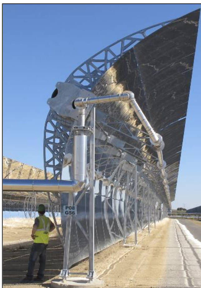
Figura 17: Collettore parabolico lineare SNT2
