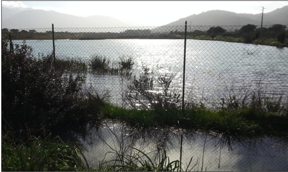
Figura 50: Bacino accumulo Calcestruzzi SpA - Momento di tracimazione
