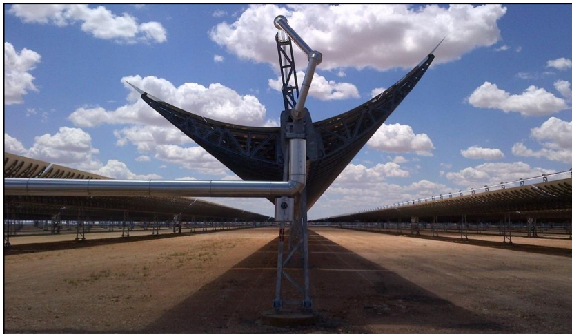
Figura 53: Esempio Raccordo Tubazioni - Tubi Ricevitori
