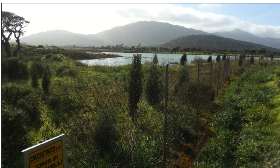
Figura 49: Bacino accumulo Calcestruzzi SpA
