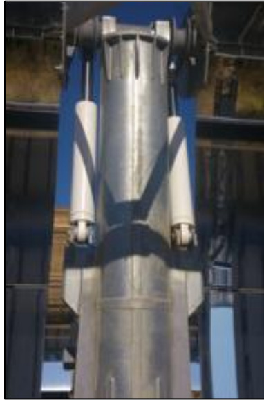
Figura 20: Drive & Tracker Pylon con Meccanismo di Trazione Tradizionale - Pistoni paralleli
