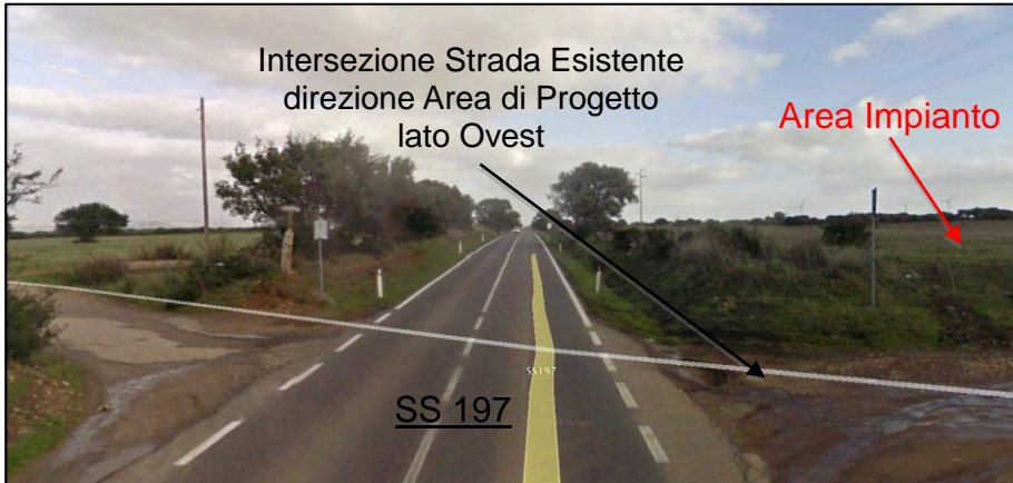
Figura 9: SS 197 - Intersezione strada esistente lato ovest Area Impianto
