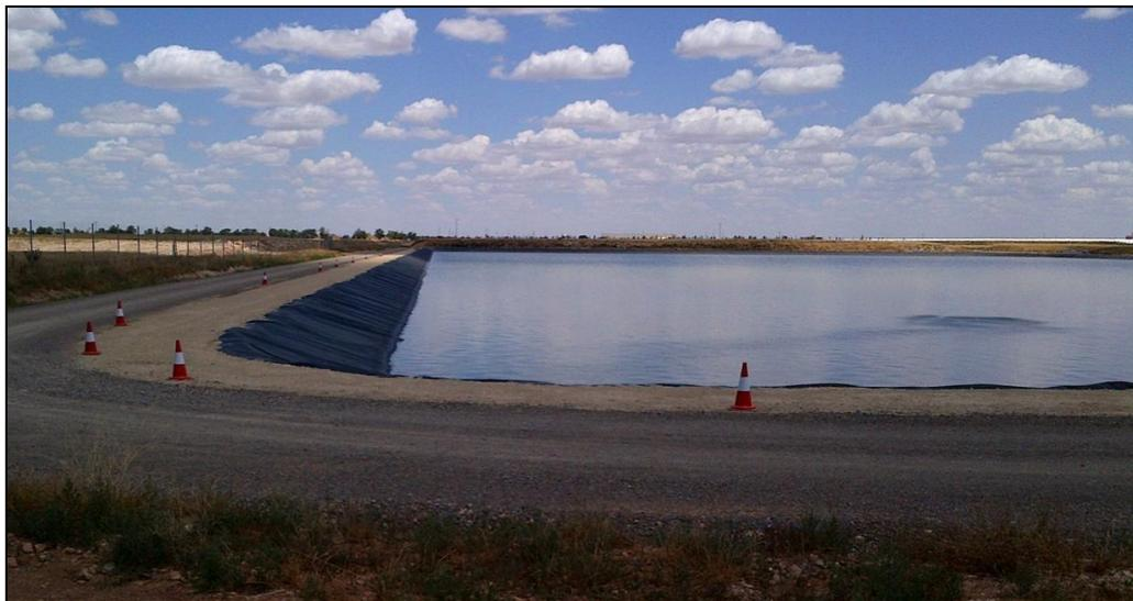
**Figura 52: Esempio di evaporation pond in una centrale CSP**
