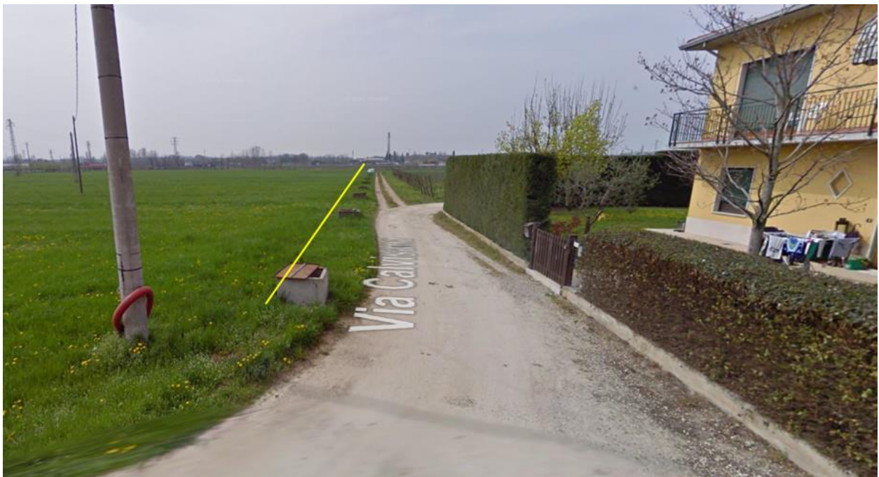
Foto 2 – Vista canale interrato con bocche lungo traversa di Via Calvisana
