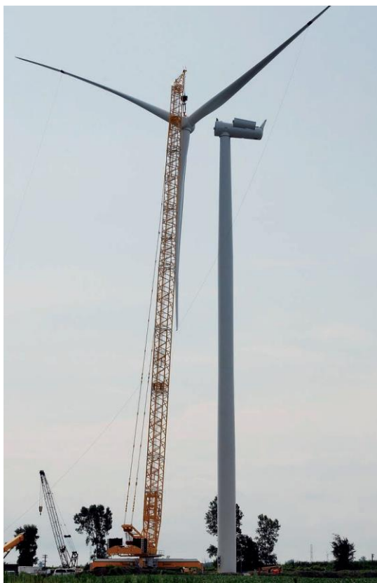
Figura 3-2: Una gru Liebherr 1750 mentre solleva un gruppo rotore per l'installazione.
