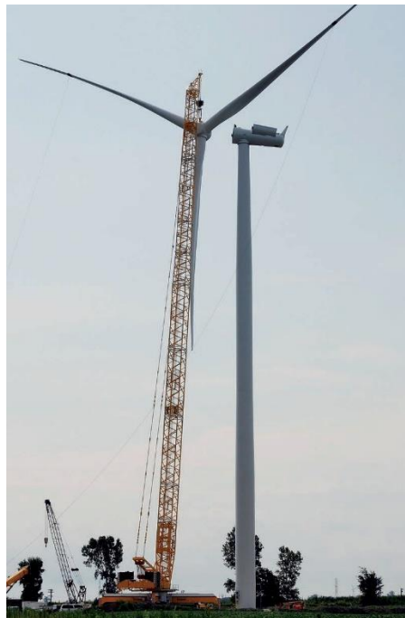
Figura 4-3: Una gru Liebherr 1750 mentre solleva un gruppo rotore per l'installazione.
